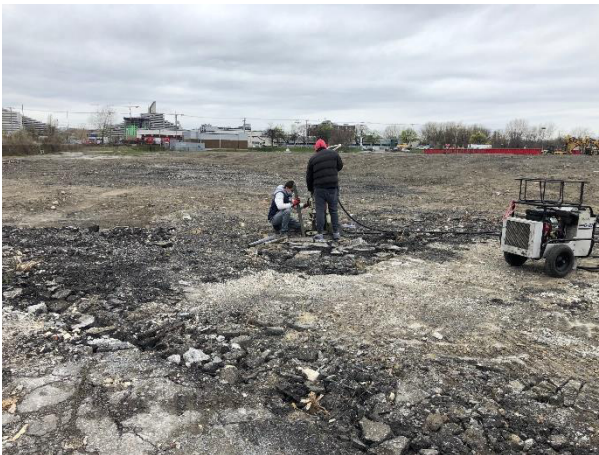
Localisation du forage F4
