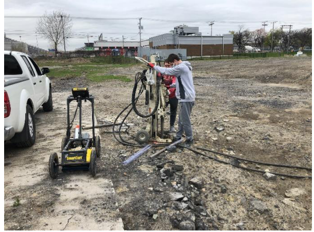
Localisation du forage F2
