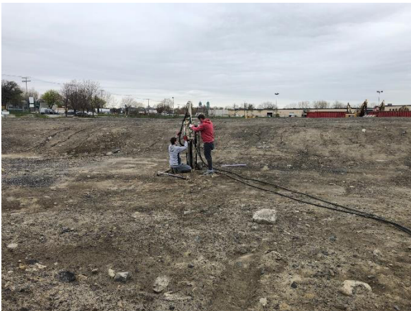
Localisation du forage F8
