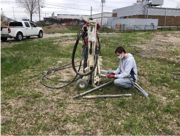
Localisation du forage F1
