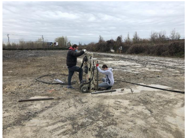
Localisation du forage F9
