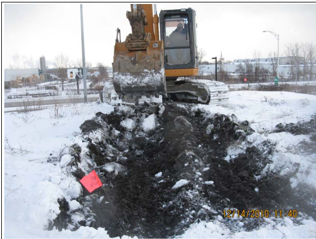
Photo No 2 – Réalisation de la tranchée TR-107.
