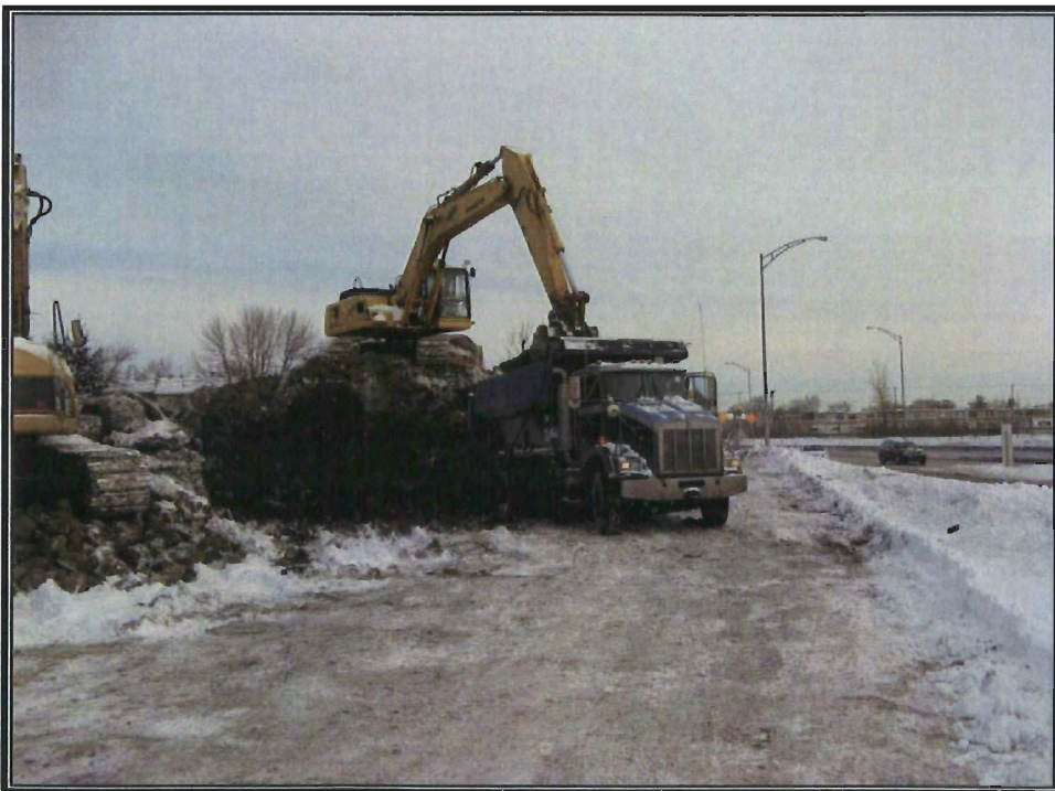
Photo 2 : Chargement des sols du talus situé au chaînage 10 + 060 (PILE-1 à PILE-11).
