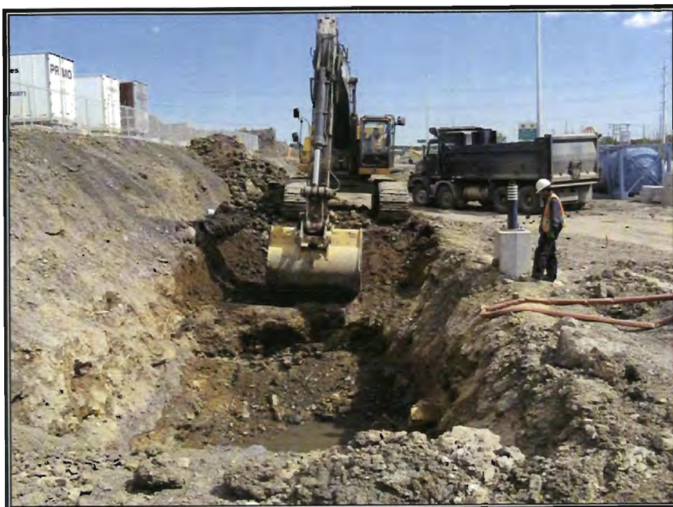
Photo 3 : Excavation des sols du secteur de l'ancien site d'enfouissement EXC-02 et EXC-03.
