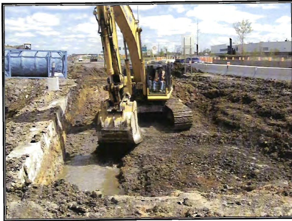
Photo 7 : Excavation des sols du secteur de l'ancien site d'enfouissement EXC-04.
