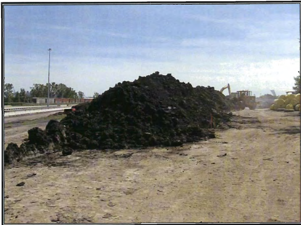
Photo 15 : PILE-16 provenant du secteur au nord du mur antibruit.
