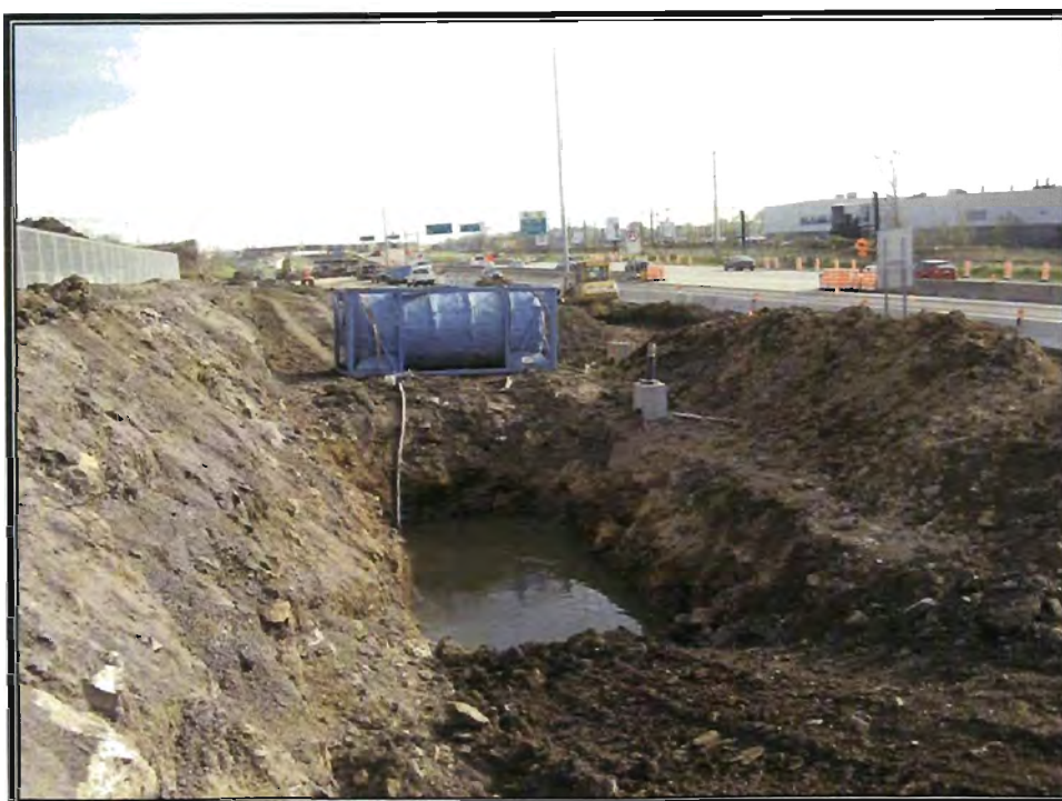
Photo 4 : Pompage de l'eau accumulée au fond de l'excavation EXC-02 vers un réservoir temporaire.
