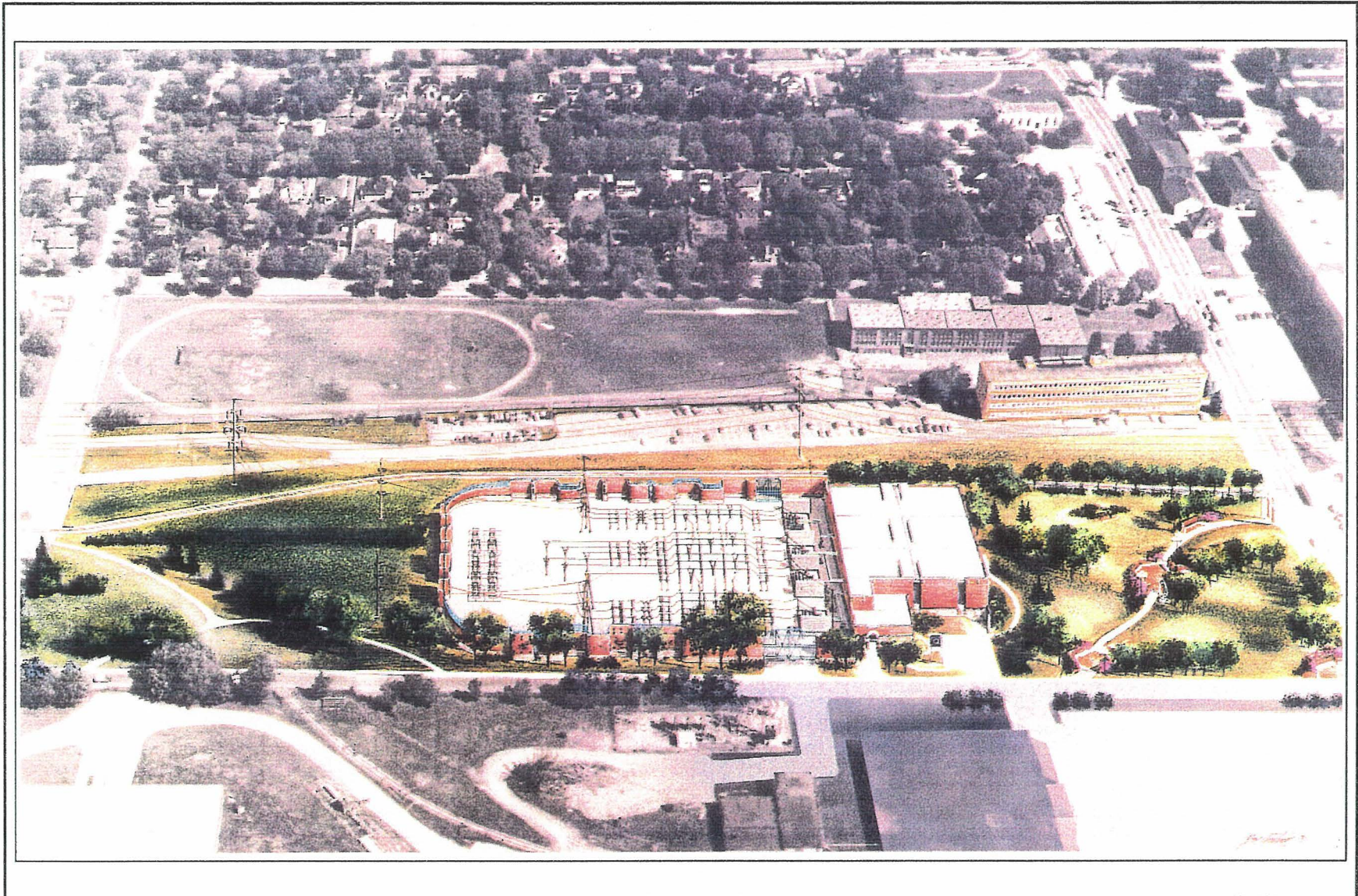
Figure 3.9: EXEMPLE D'UNE SIMULATION PAR PHOTO-RETOUCHE, PROCÉDÉ MANUEL Poste Des Chenaux à 230-25 kV
