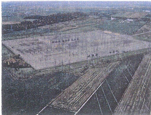
Figure 4.2 Problématique d'intégration de l'équipement liée à la nature de l'équipement projeté Les caractéristiques spécifiques de l'équipement électrique concourent à la définition d'une problématique particulière d'intégration
