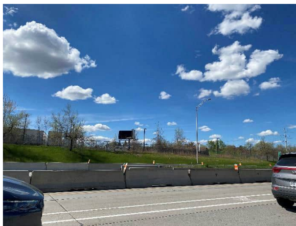
PHOTO 32 Vue du secteur du circuit 3213 au nord de l'avenue Souigny
