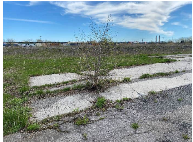
PHOTO 4 Vue des vestiges de l'ancien bâtiment qui se trouvait sur le lot 6 573 742
