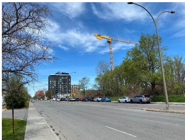
PHOTO 11 Vue du boulevard de l'Assomption
