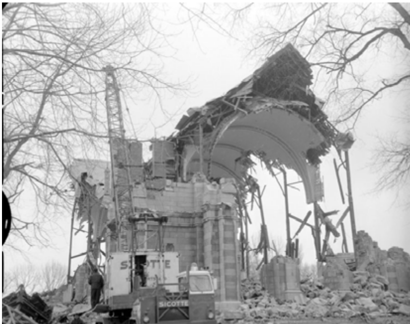
Figure 16 Travaux de démolition de l'église Saint-François-d'Assise à Longue-Pointe, Adrien Hubert, 1964 (BAnQ E6,S7,SS1,D640640-640652 )
