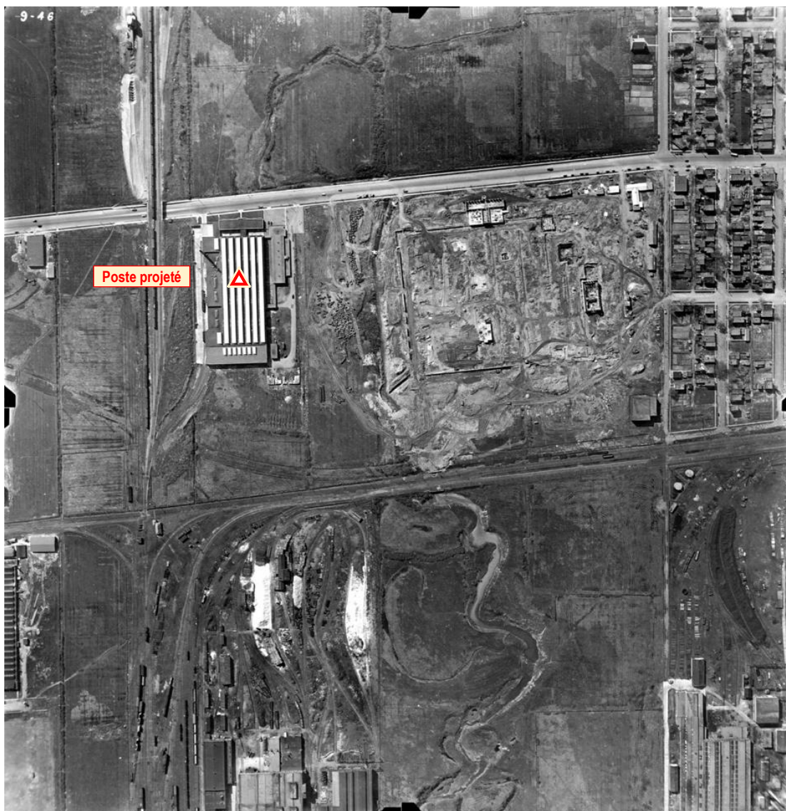
Figure 8-6 : Vue aérienne de la zone d'étude en 1947
