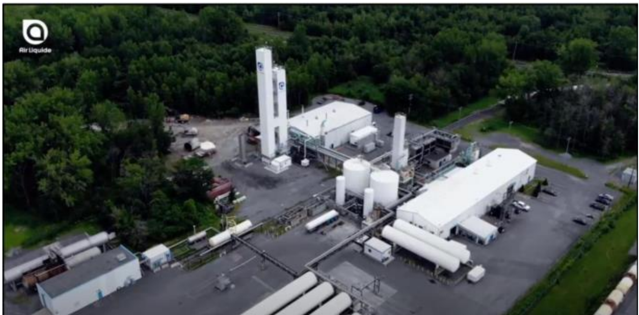
Figure 1-1 Unité de séparation de l'air de Varennes
