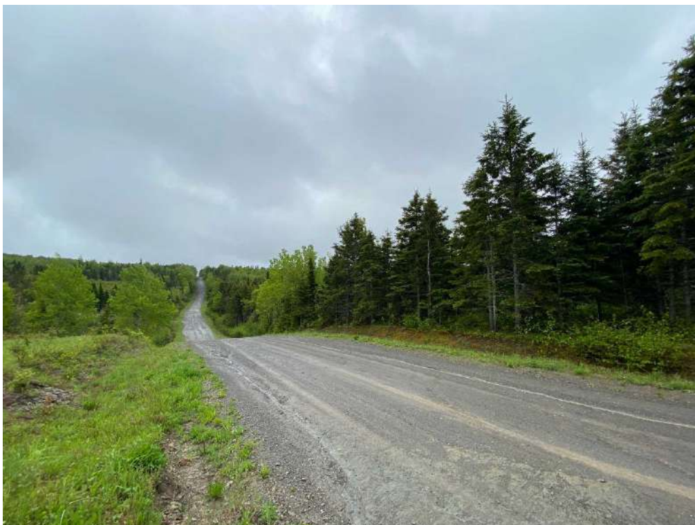
35. Station HIMA-08 vue vers le sud (2024-05-29)
