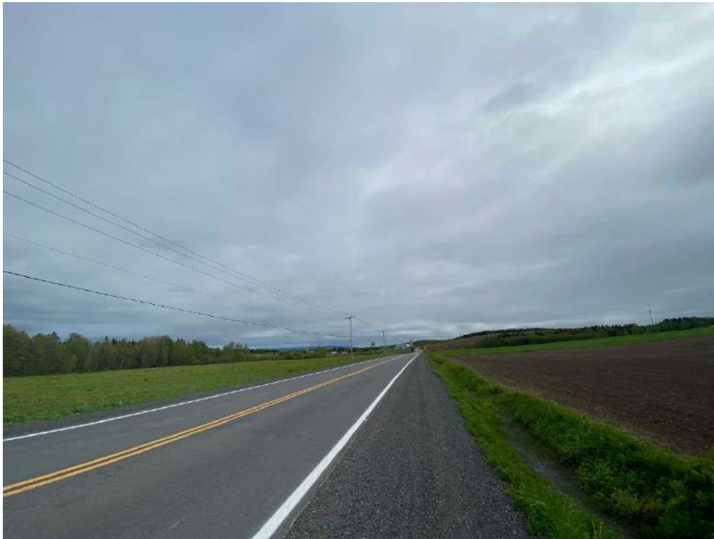
87. Station HIMA-21 vue vers le sud (2024-05-29)
