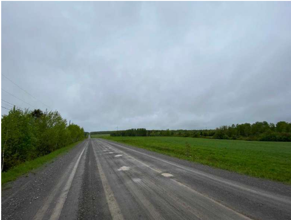
21. Station HIMA-05 vue vers le nord (2024-05-29)
