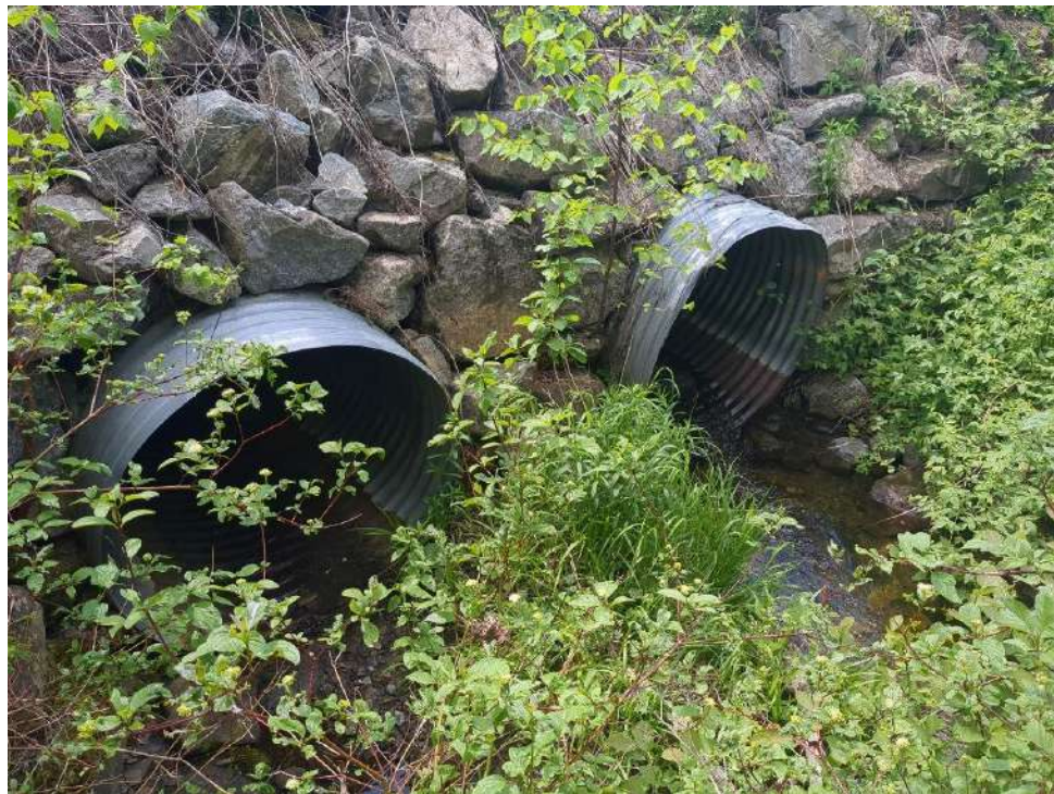
28. Ponceau CE-44, aval
