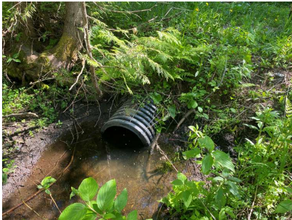
2. Ponceau CE-12, aval
