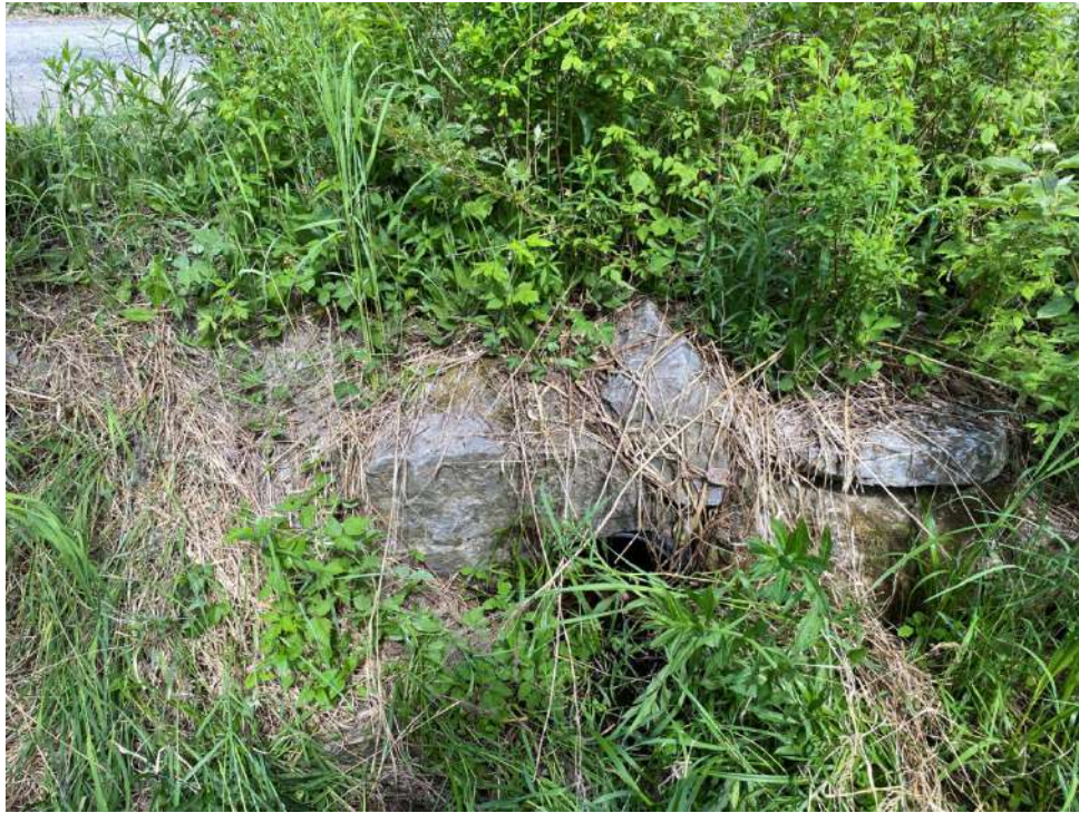
23. Ponceau CE-42, amont
