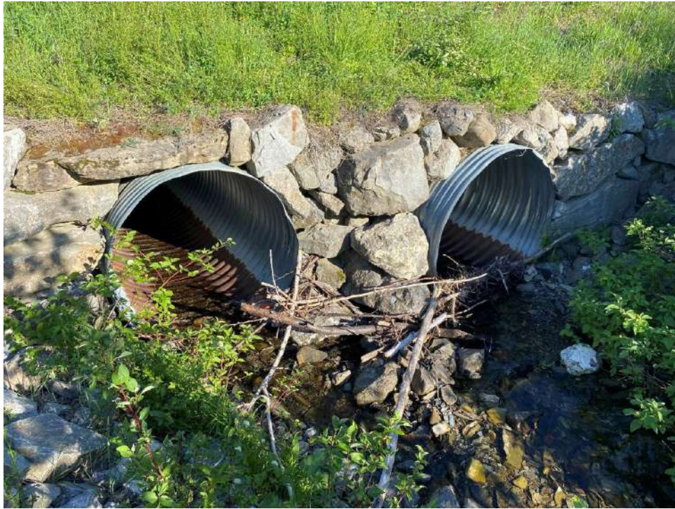
31. Ponceau CE-48, amont
