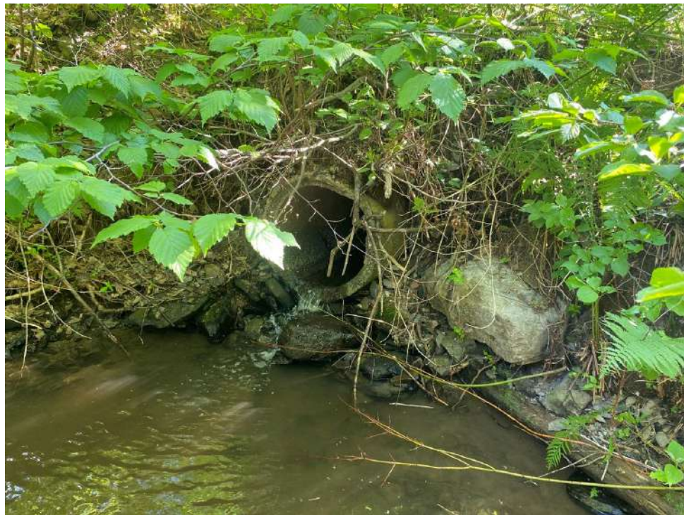
30. Ponceau CE-47, aval
