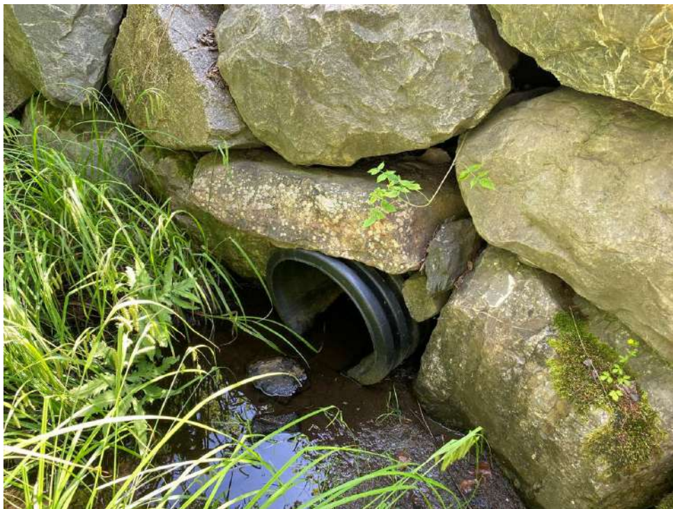
40. Ponceau CE-57, amont
