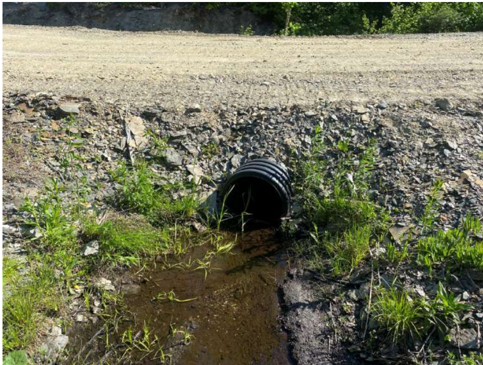
19. Ponceau CE-40, amont
