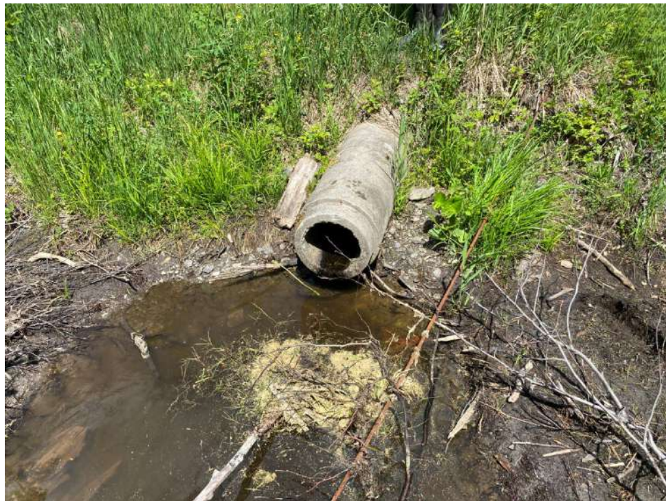
10. Ponceau CE-20, aval
