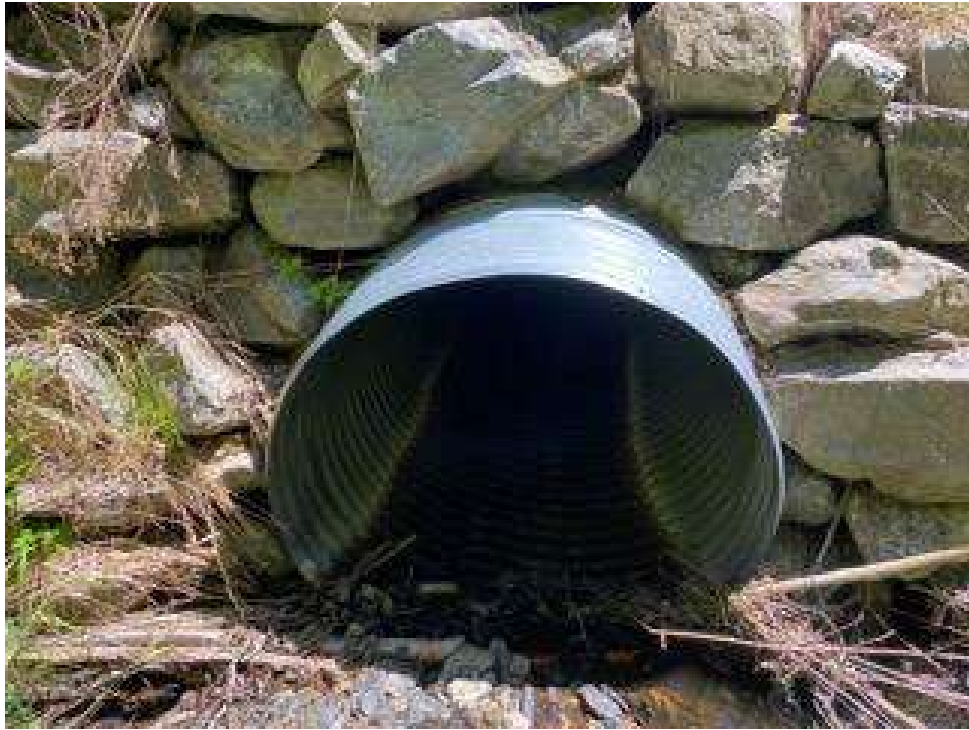
25. Ponceau CE-43, amont
