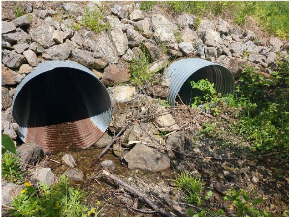
27. Ponceau CE-44, amont
