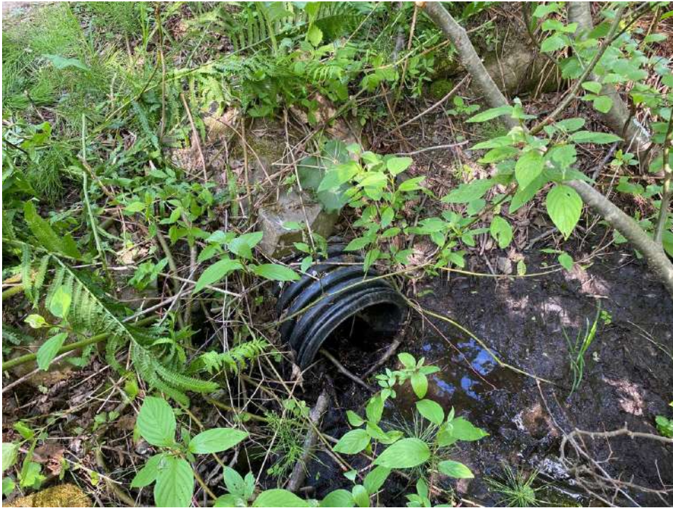
15. Ponceau CE-33, amont
