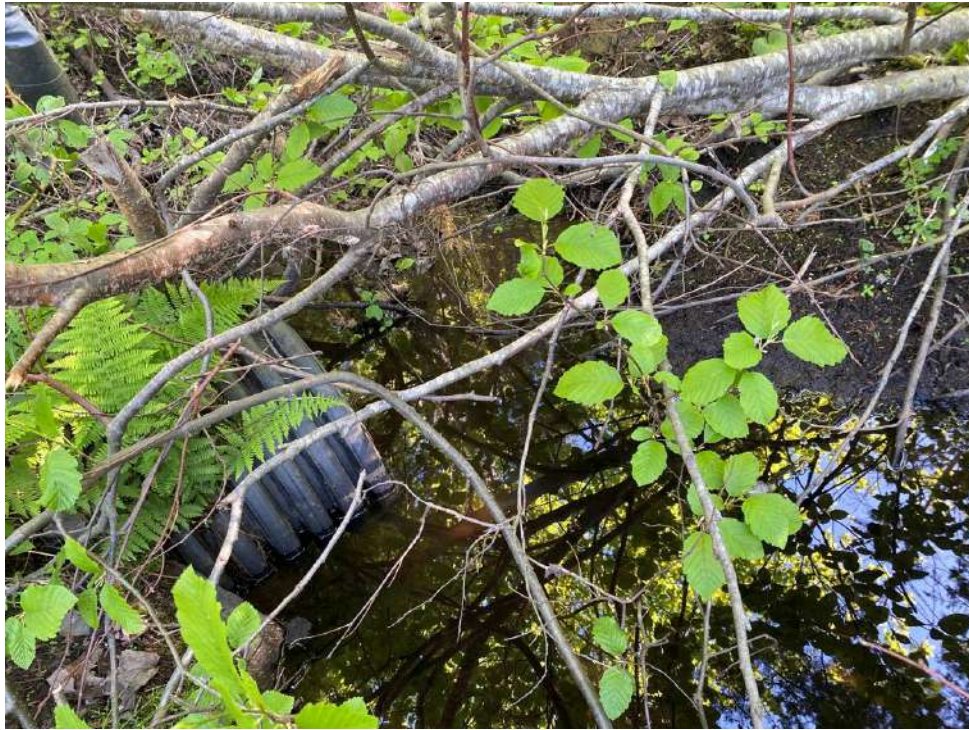
1. Ponceau CE-12, amont
