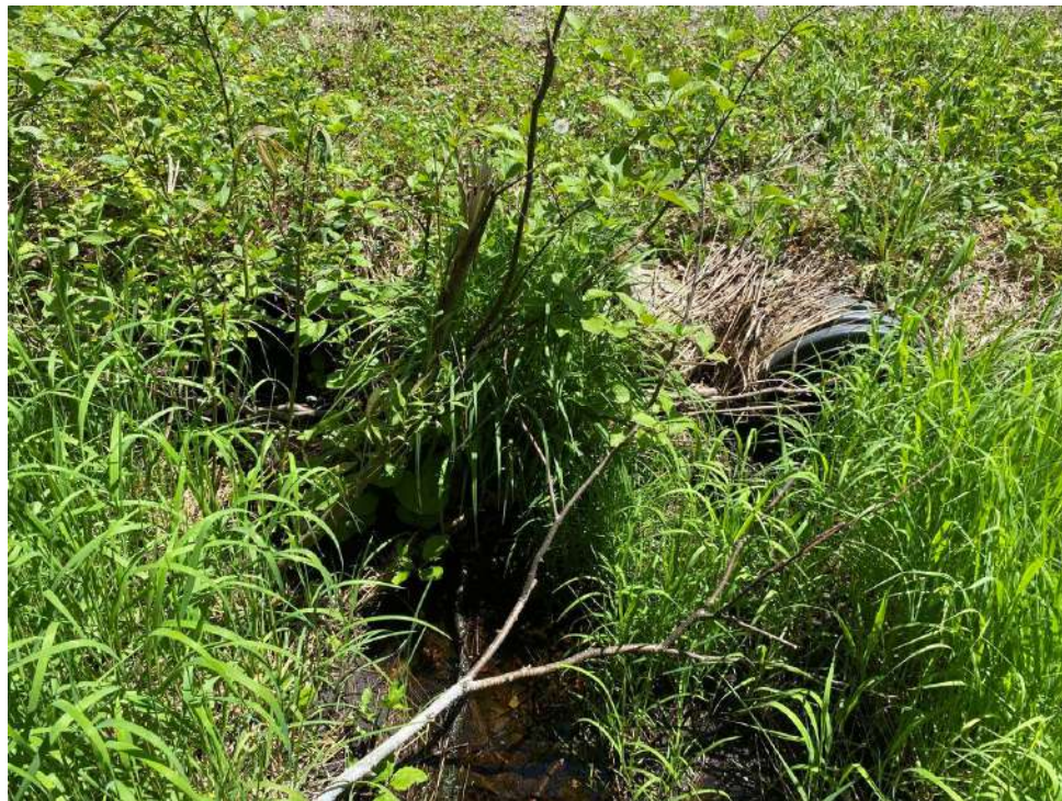
22. Ponceau CE-41, aval
