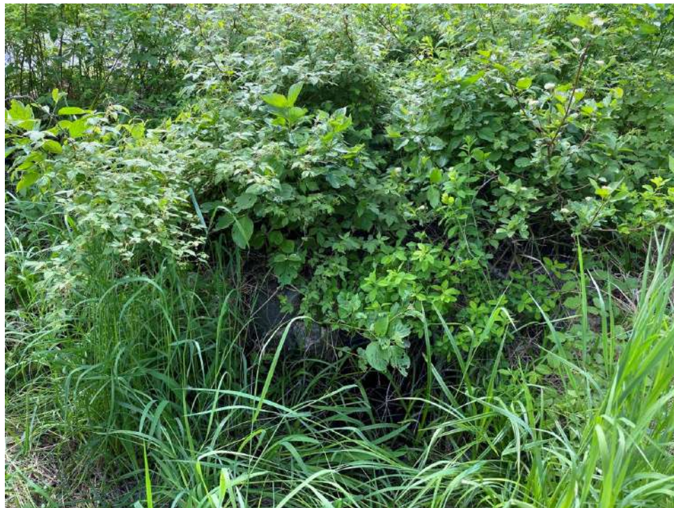
24. Ponceau CE-42, aval
