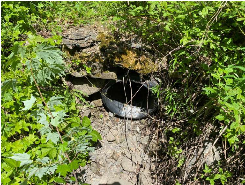
11. Ponceau CE-30, amont
