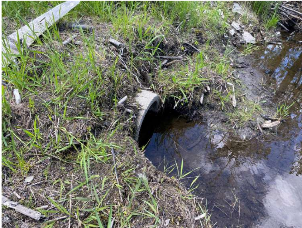
9. Ponceau CE-20, amont
