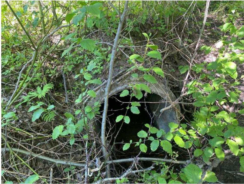
29. Ponceau CE-47, amont
