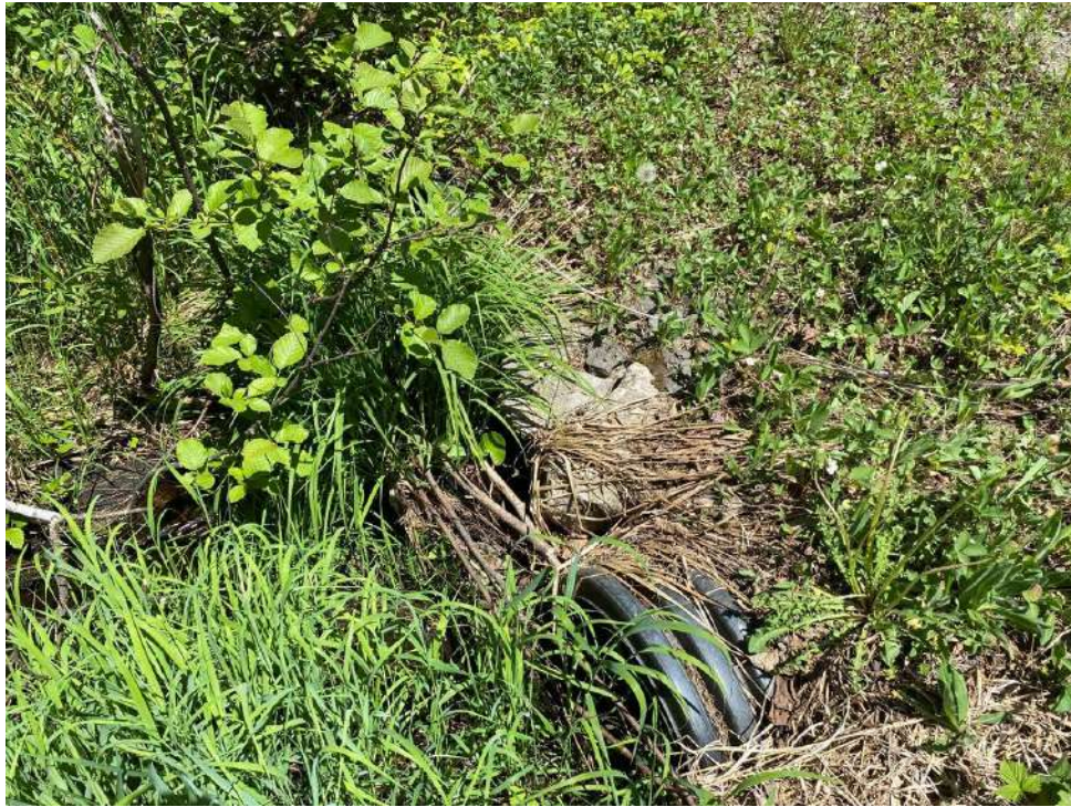
21. Ponceau CE-41, amont
