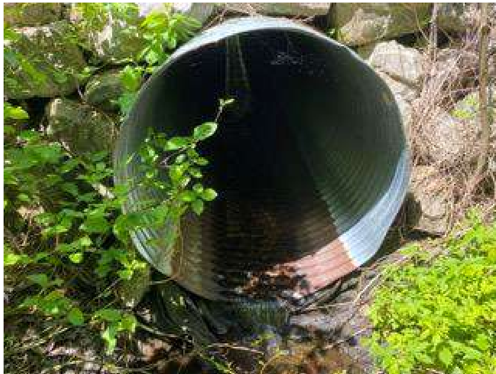
26. Ponceau CE-43, aval
