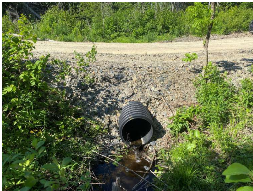
20. Ponceau CE-40, aval
