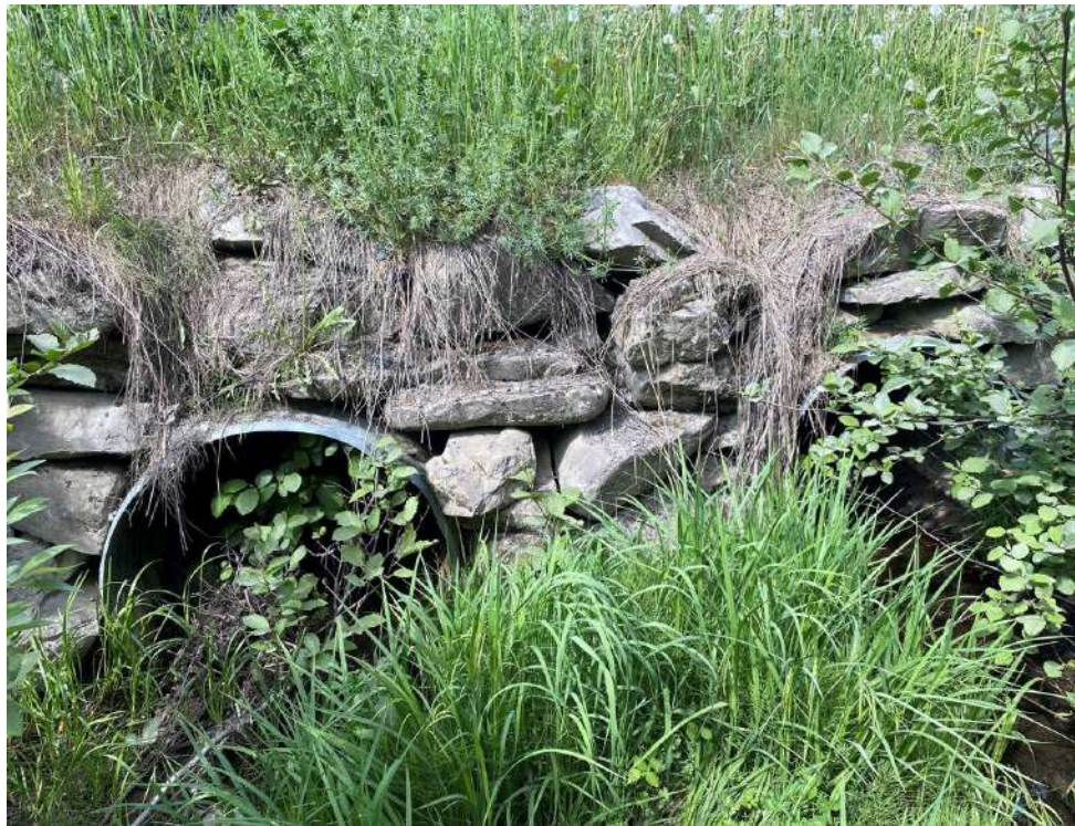
18. Ponceau CE-34, aval
