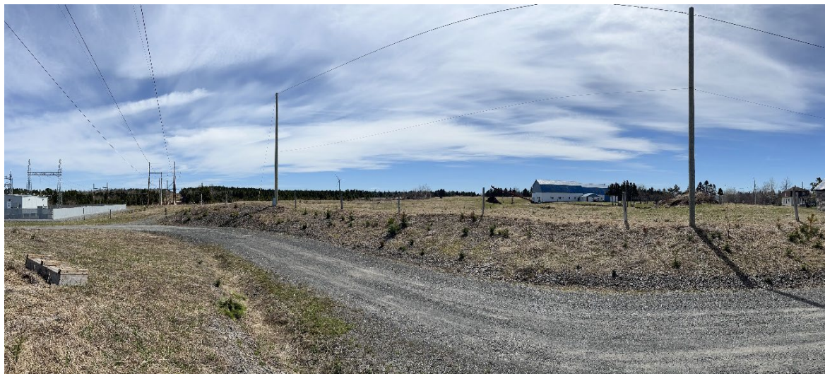
1. Point d'observation OP01 vue vers le sud-est (2023-05-05)
