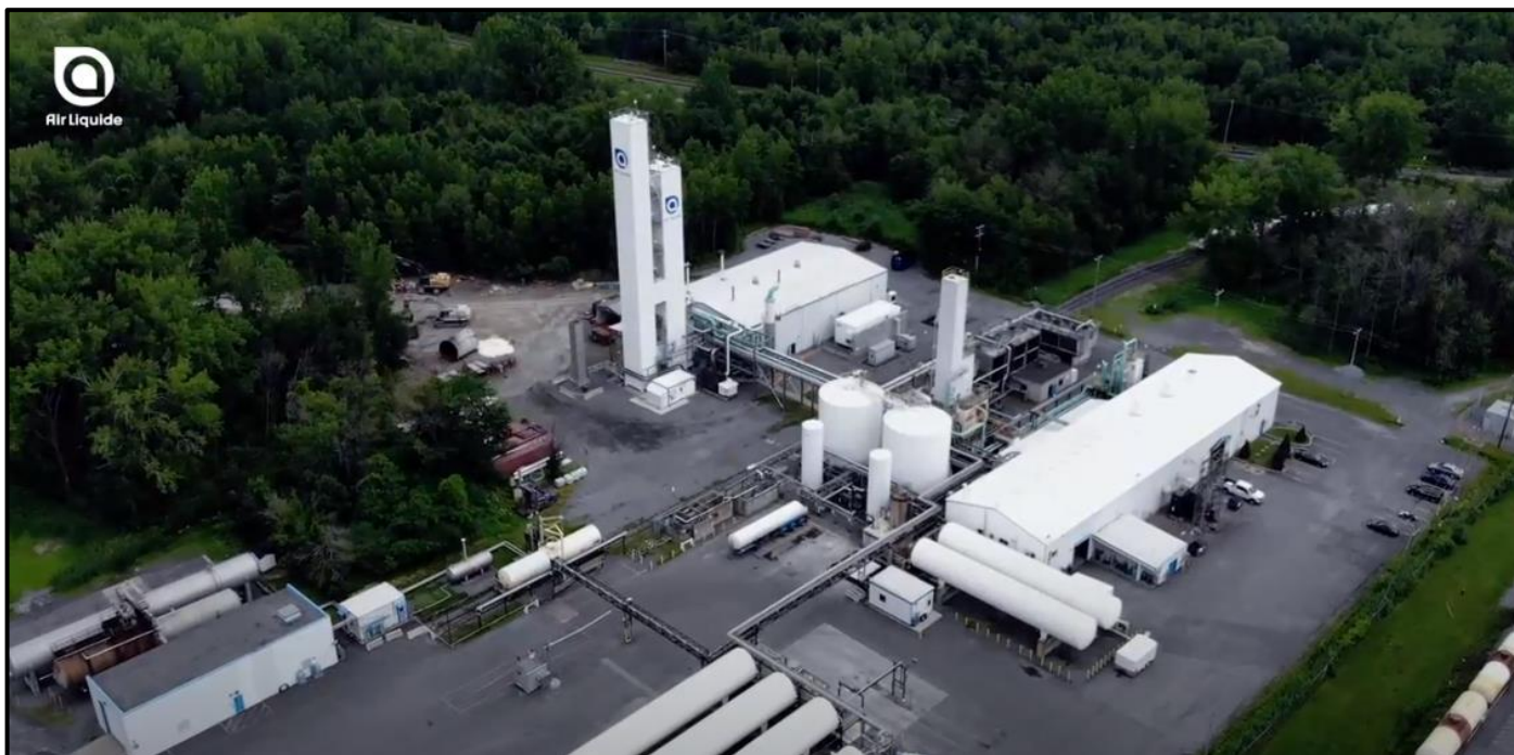
Figure 3-1 Unité de séparation de l'air de Varennes
