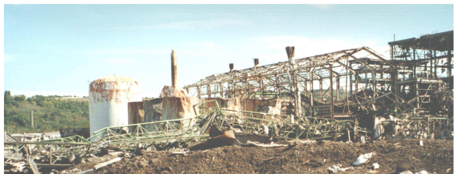
Figure 7. Conséquence de l'explosion de l'usine AZF dans l'entourage immédiat de l'atelier
