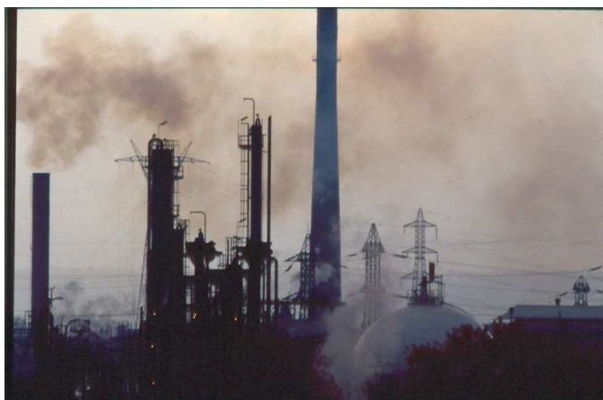
Figure 4. Sphère de Gaz de Pétrole Liquéfié et unité de craquage de pétrole dans une raffinerie
