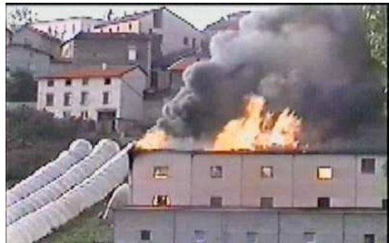
Figure 6. Incendie d'un entrepôt
