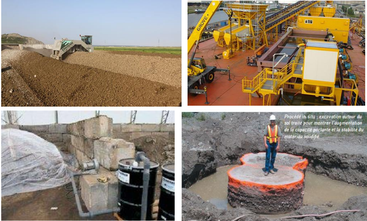
Figure 11. En haut à gauche: Biotraitement. En haut à droite: Hydro cyclonage. En bas à gauche: Extraction sous vacuum. En bas à droite: Exemple d'une structure solide obtenue par stabilisation/solidification. (Tirées de : Envisan; Horizon environnement; Ciment Québec)
