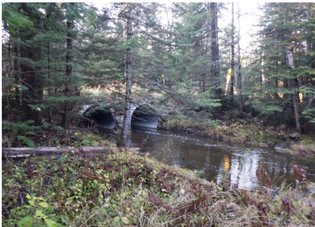
Photo 25 Zone 8, vue des ponceaux aménagés sous le chemin forestier afin de permettre l'écoulement de la rivière Nebnellis (photo prise vers le nord-est)
