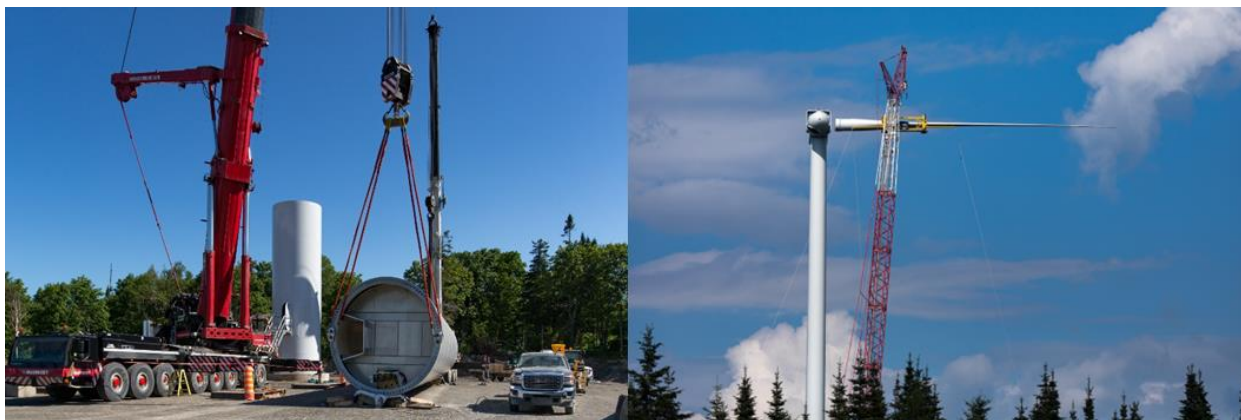
Figure 4-7 - Montage des éoliennes (source : EDF)
