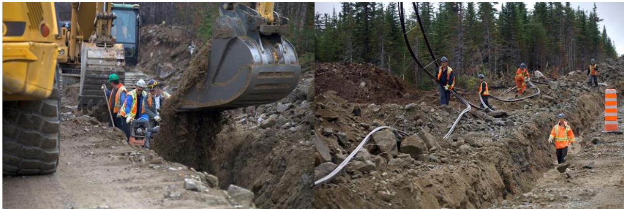
Figure 4-8 - Installation du réseau collecteur (source : EDF)
