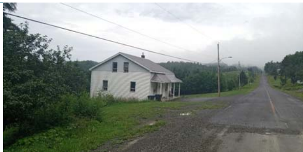
Description : Direction NO img-20240716-131845.jpg
