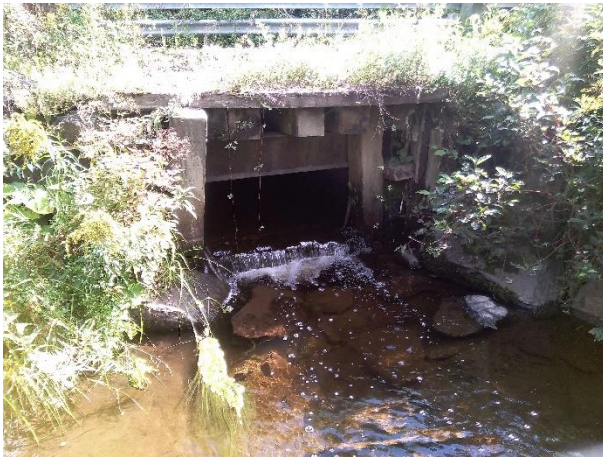
Photo 11. Infrastructure de traversée de cours d'eau (SEC36)
