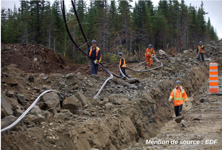
Figure 7. Installation d'un réseau collecteur souterrain
