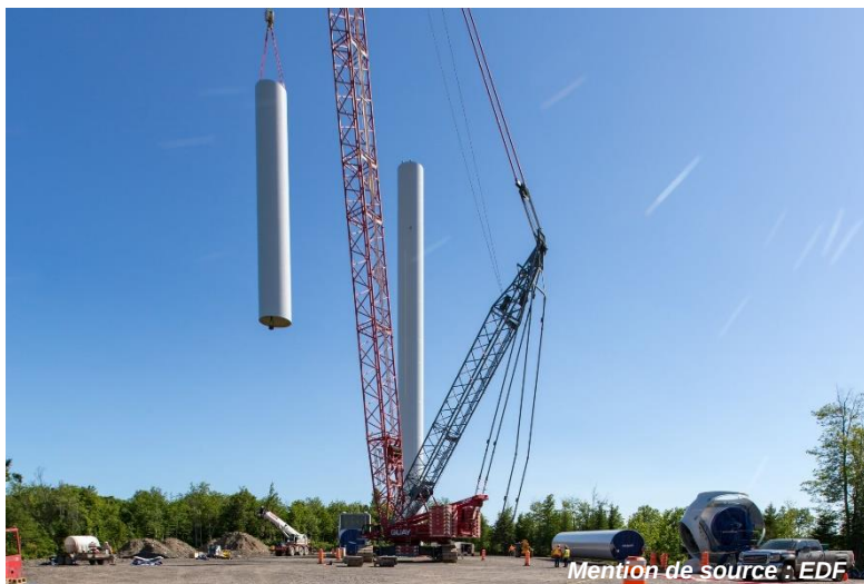
Figure 6. Assemblage d'une tour et d'une pale d'éolienne
