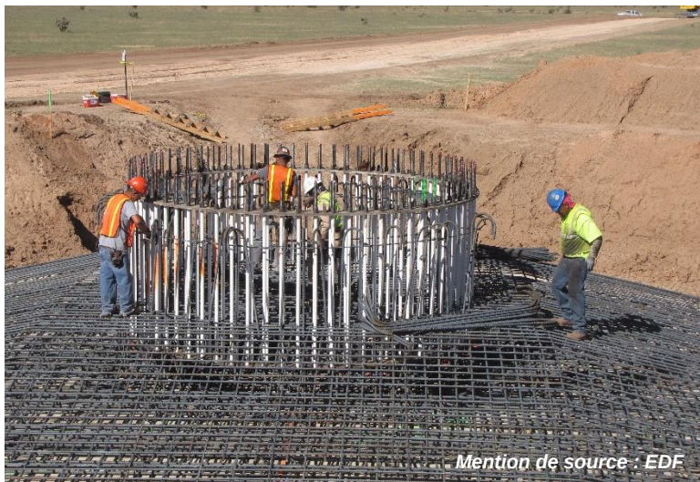
Figure 5. Construction d'une fondation d'éolienne de type gravitaire
