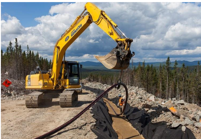
Figure 3.5 Installation d'un réseau collecteur souterrain
