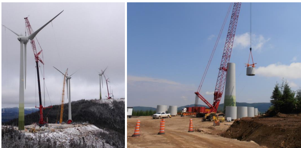
Figure 3.4 Assemblage d'une tour d'éolienne par section
