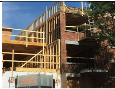
Détail du mur mitoyen en colombage - 2016
