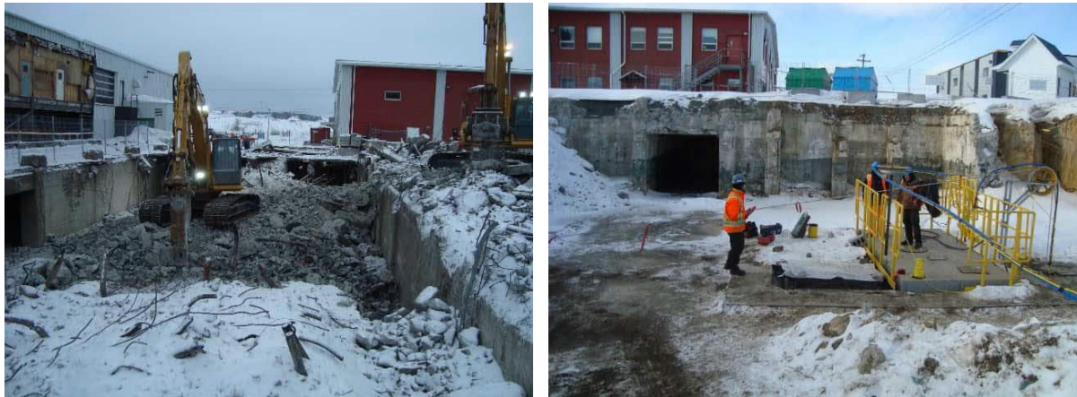
Figure 2. Travaux de démantèlement de structures de l'ancienne mine Quémont
