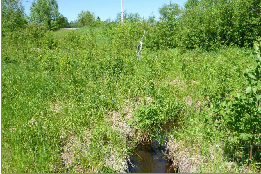
Photo 9 : Ruisseau CE-01 (tracé des conduites)
