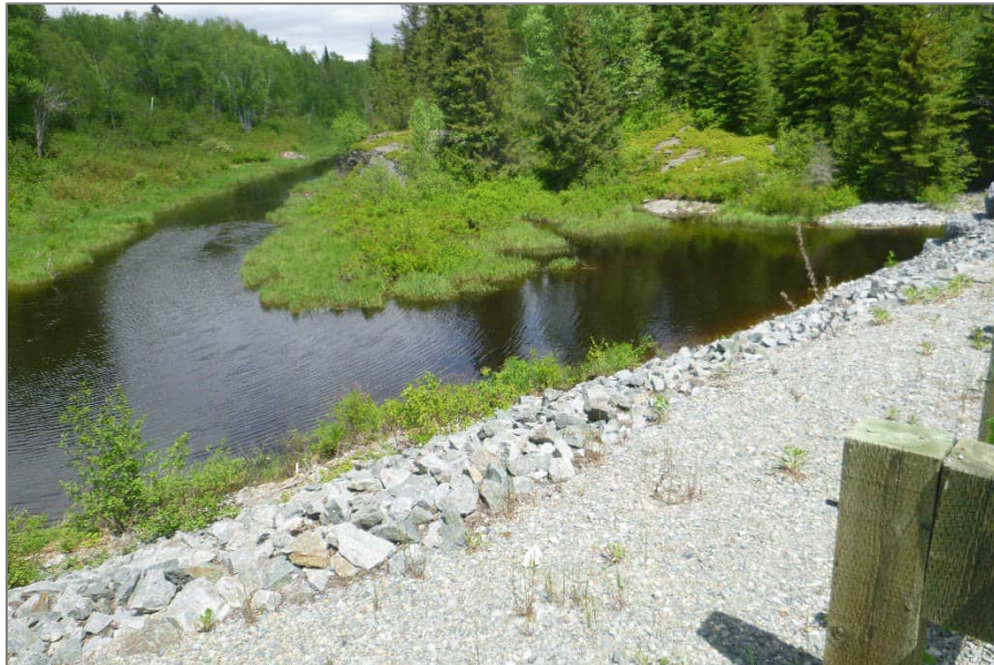
Photo 18 : Ruisseau CE-10 (tracé des conduites)
