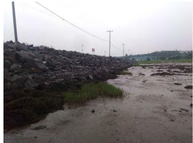
Photo 18. Ouvrage de protection inclus dans le littoral, unité U16
