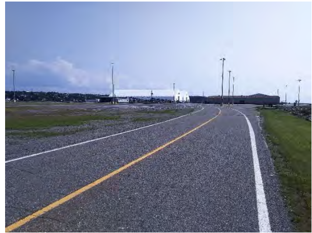
Photo 22. Route pavée, unité U14
