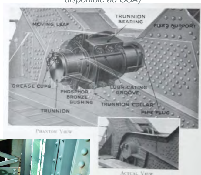
Figure 3.10 Système de pivot présenté dans la brochure publicitaire de compagnie de génie Strauss (source (Company, 1920) p. 4 disponible au CCA)
