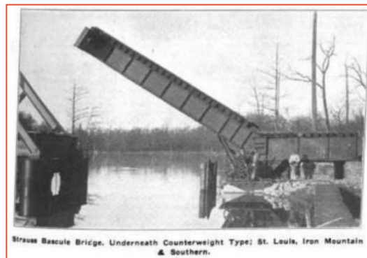
Figure 3.12 Pont Strauss à bascule avec le contrepoids en dessous du tablier (source : (Corporation, 1908) p. 385 disponible au CCA)
