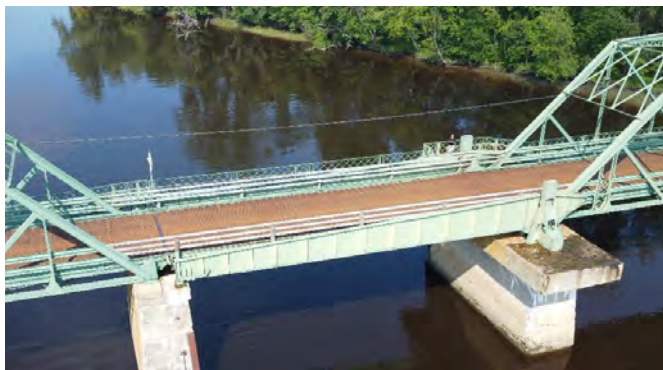
Figure 3.13 Vue de la partie centrale à bascule - Août 2023 (Source: FL)
