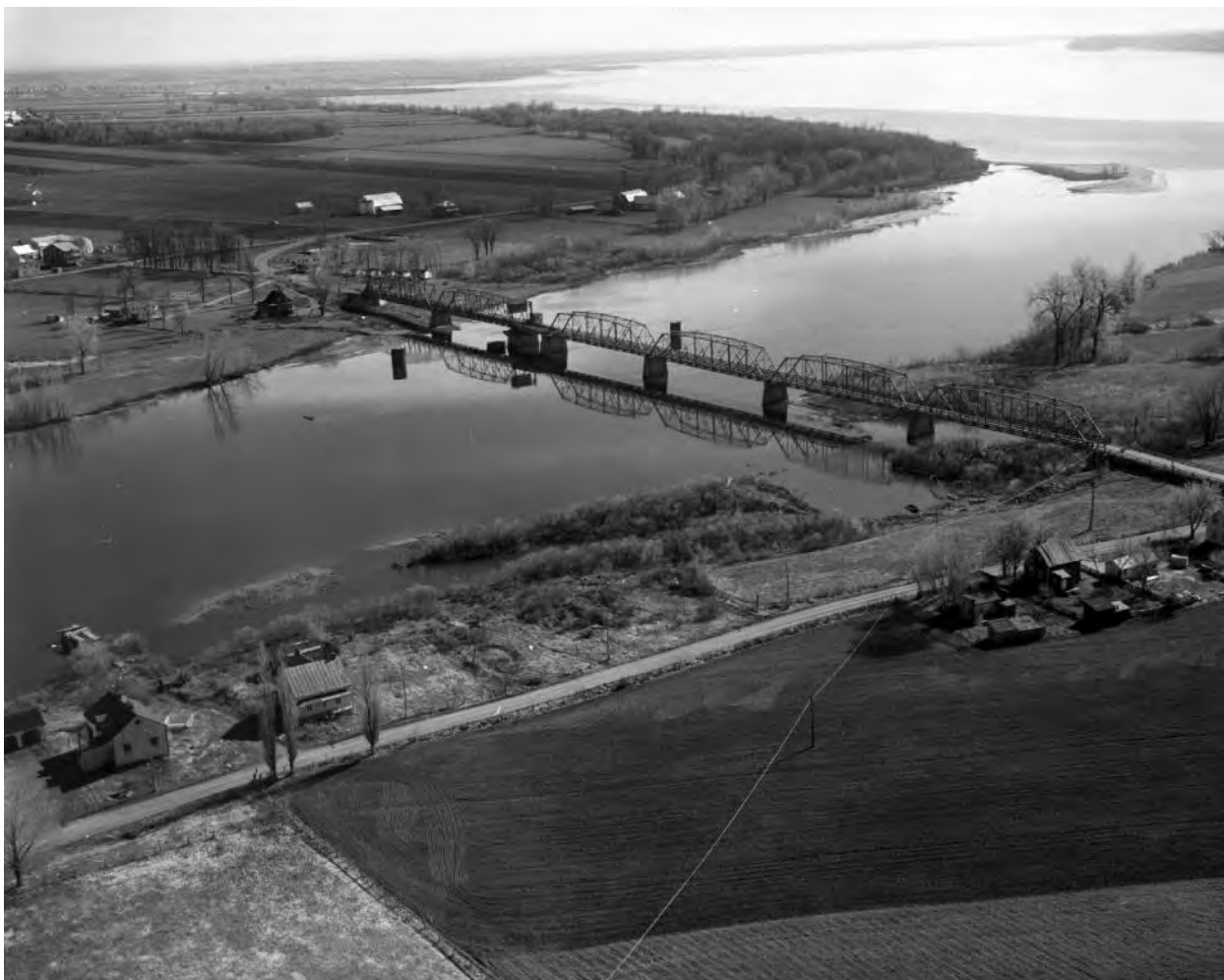
Figure 3.25 Vue du pont en 1959. On note la présence du contrepoids, la petitesse de la travée basculante, ainsi que des petits chalets du Campement Idéal situés sur le site de l'actuelle marina (Source : Armour Landry, BAnQ)
