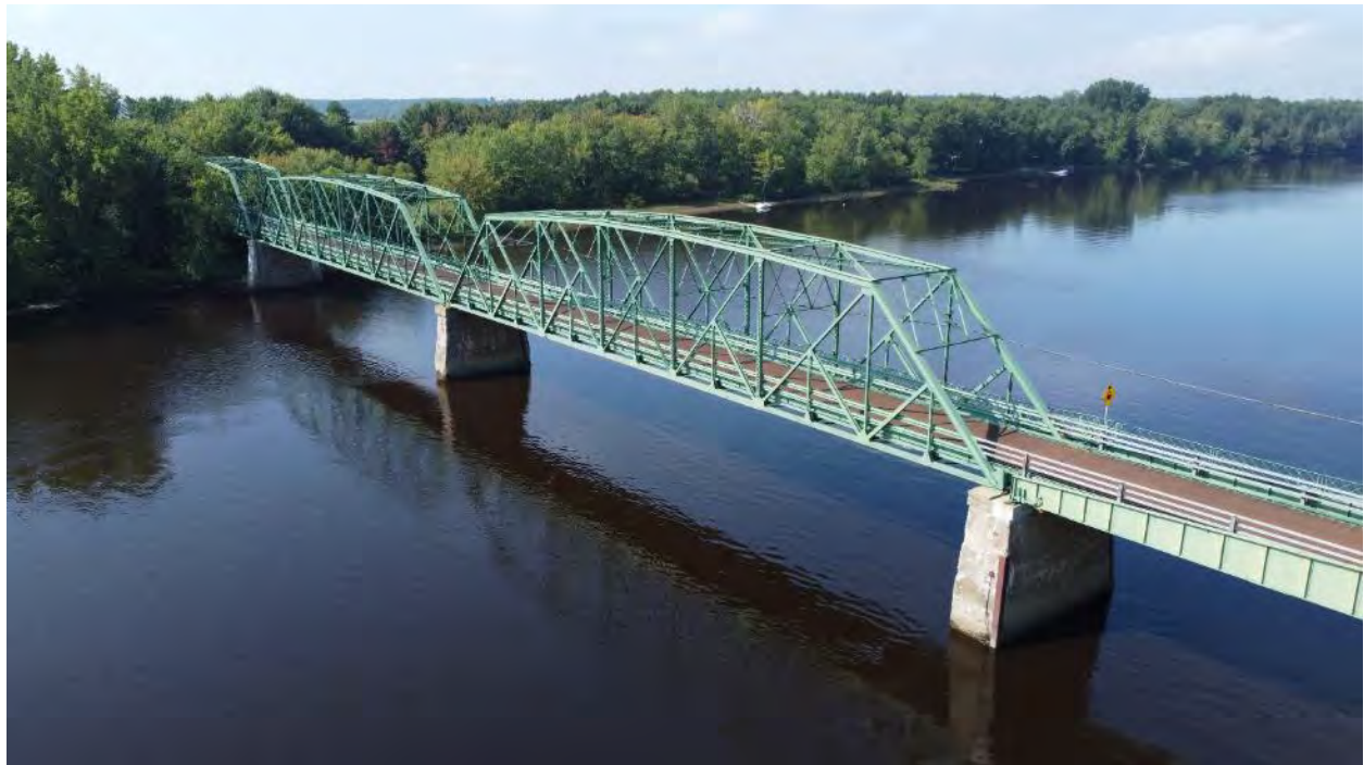
Figure 3.15 Vue des deux travées fixes à l'ouest de la bascule centrale – Août 2023 (Source : FL)
