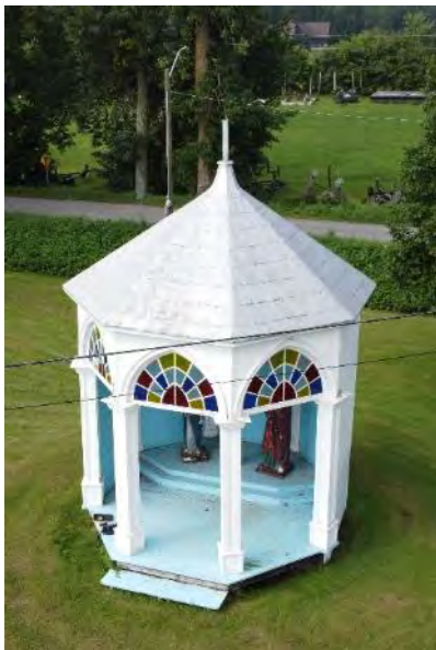
Figure 3.26 Vue du Calvaire Lacoursière et de son toit en zinc - Août 2023 (Source: FL)
