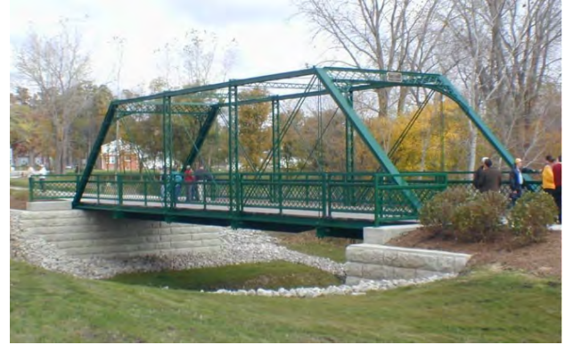
Figure 4.2 Restauration et réutilisation du pont de Morenci, Michigan (Source : https://bachsteel.com/projects/sterling.pdf )
