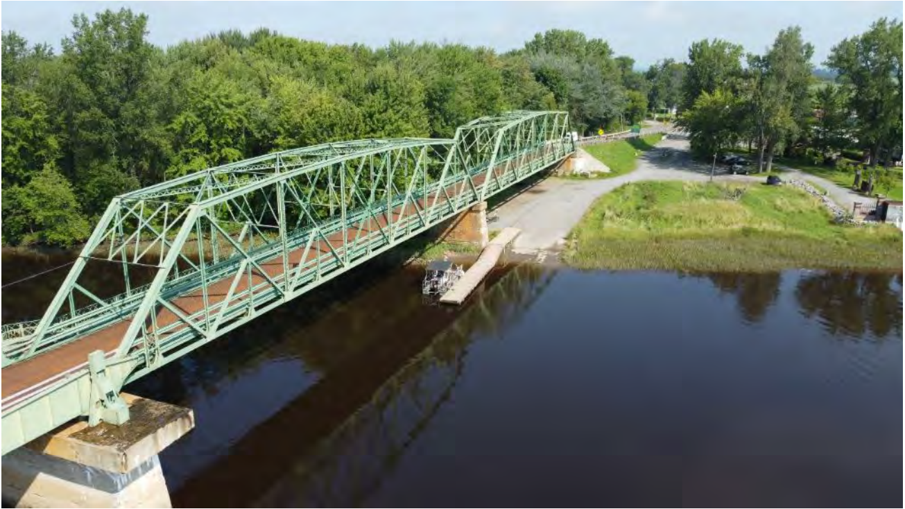
Figure 3.14 Vue des deux travées fixes à l'est de la bascule centrale - Août 2023 (Source : FL)
