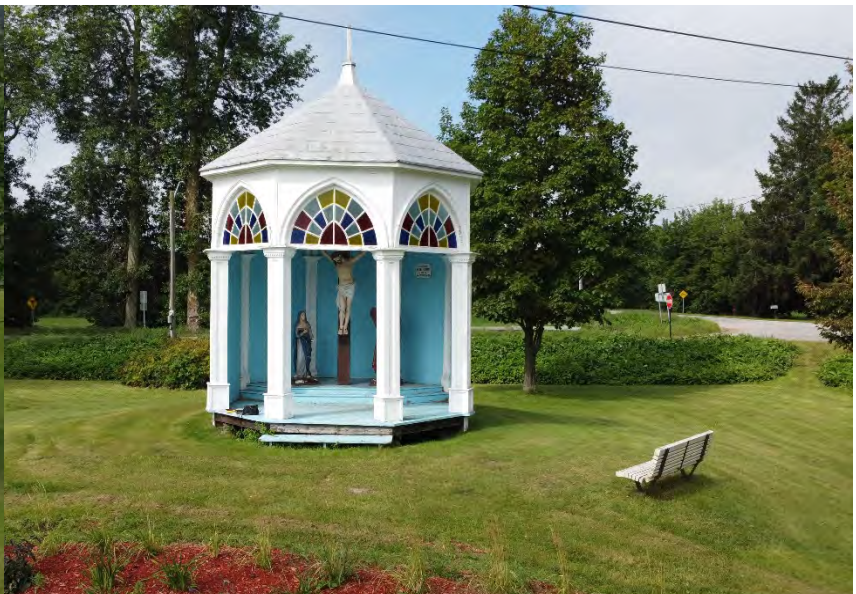
Figure 3.27 Vue du Calvaire Lacoursière et de son toit en zinc - Août 2023 (Source: FL)
