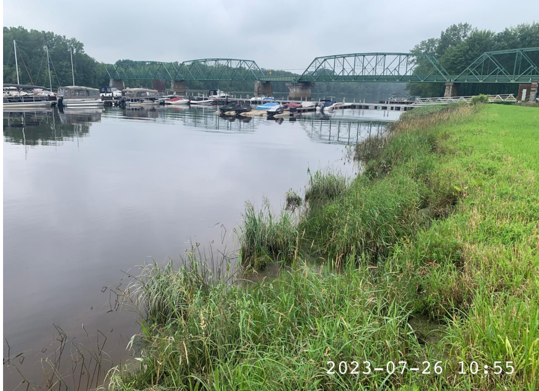
Figure 3.6 : Fissuration et décrochement de la rive (zone 2)
