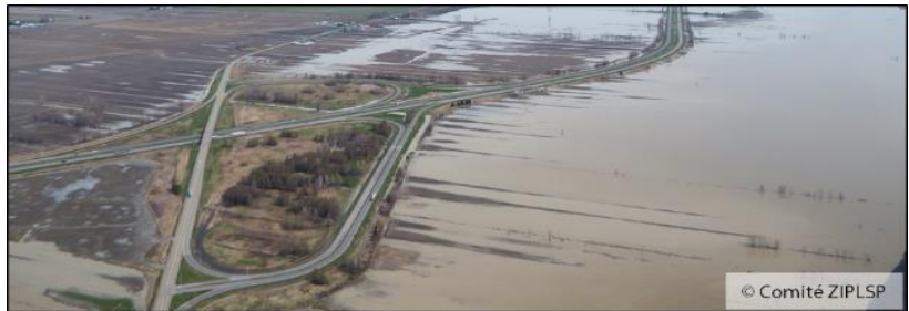
Figure 8. Vue aérienne de l'autoroute 40 dans la zone inondable du lac Saint-Pierre
