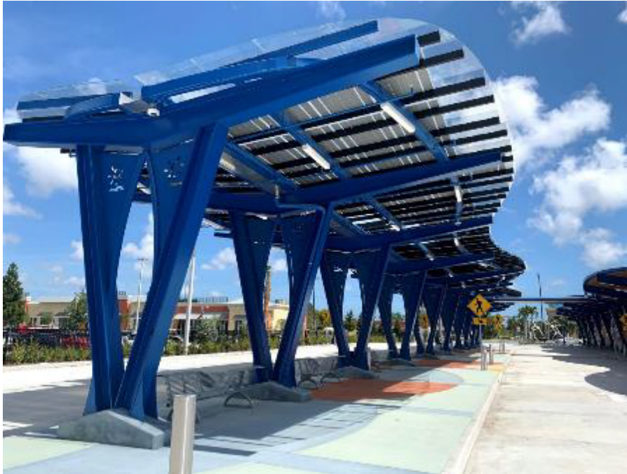
Figure 9 Installation de modules sans cadre au Mall Mass Transit Center à Lauderdale (Floride) (source : lumossolar.com)
