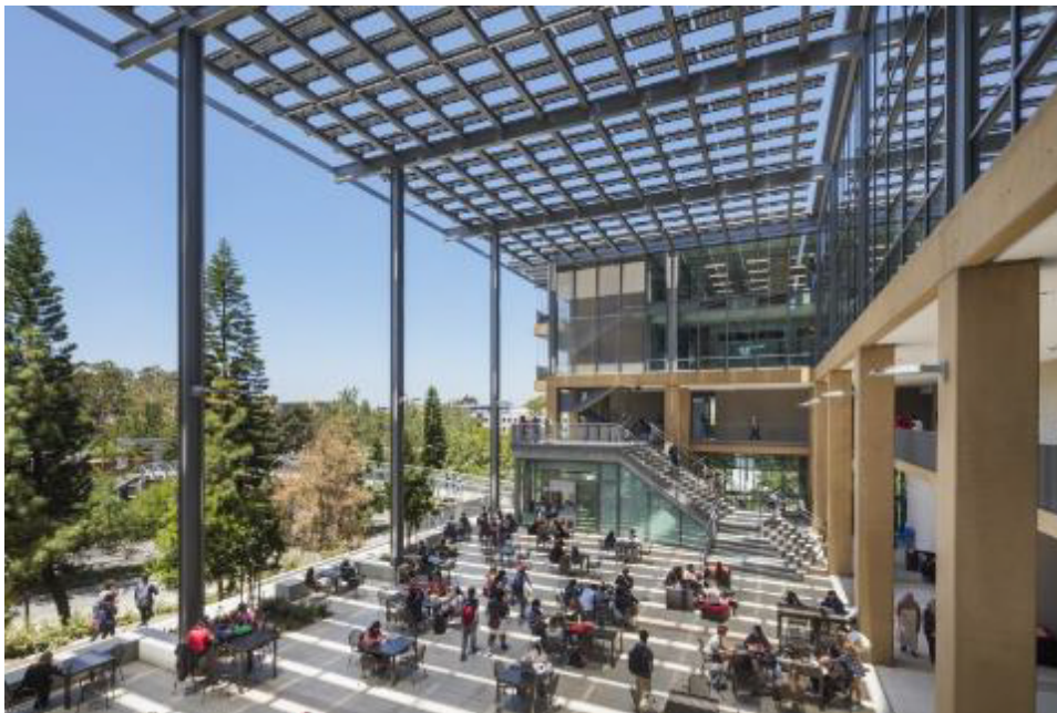
Figure 10 Installation de modules sans cadre à l'Université de Californie à Irvine (Californie) (source : lumossolar.com)
