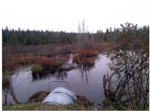
Photo 4. Traverse de cours d'eau T001 (amont), CE139
