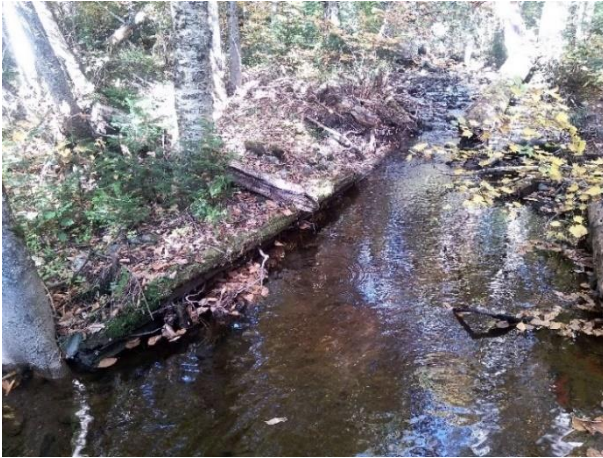
Photo 5. Ancienne frayère aménagée à restaurer
