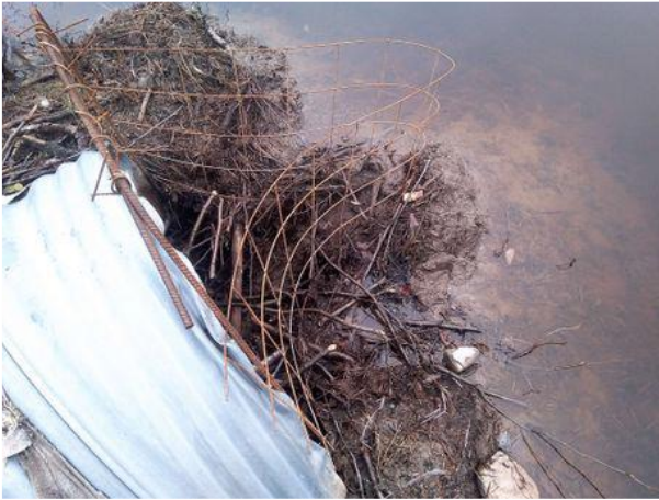
Photo 3. Traverse de cours d'eau T001 (amont), CE139
