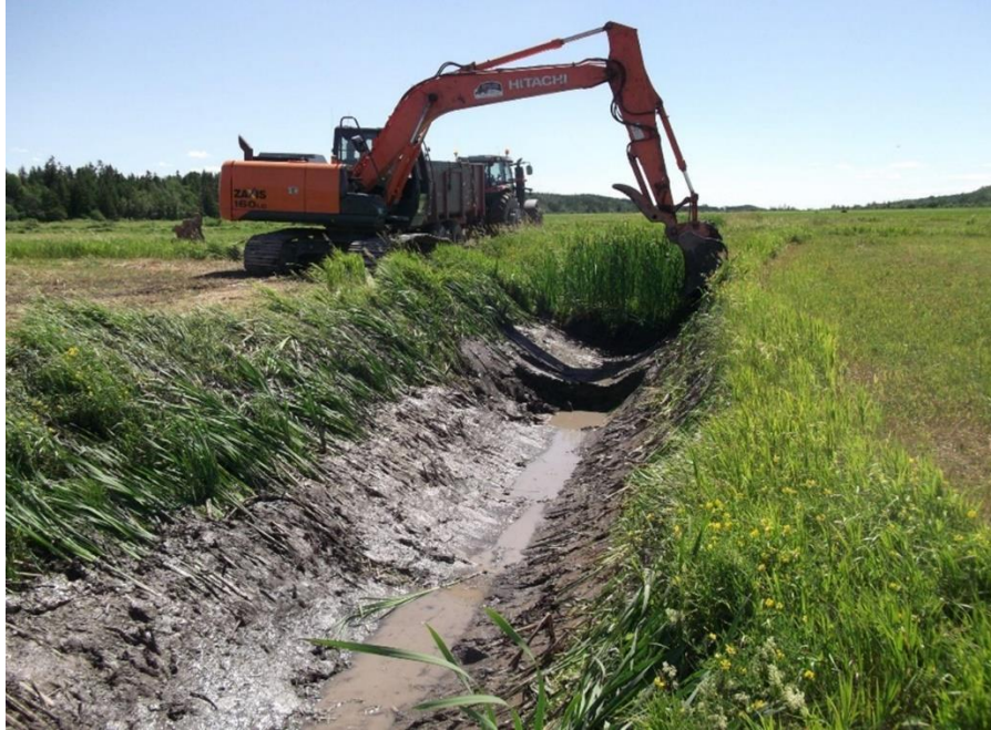
Figure 2.21. Travaux d'entretien de cours d'eau exécutés par la MRC à Saint-Denis-De La Bouteillerie
