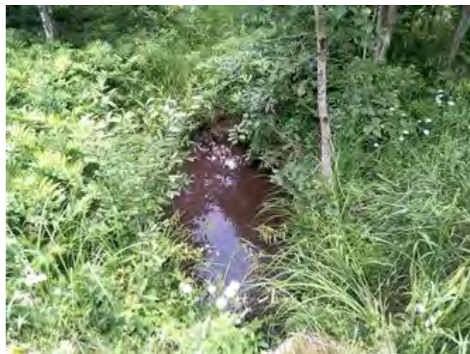
Vue aval de l'infrastructure existante
