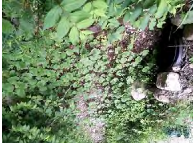
Vue amont de l'infrastructure existante
