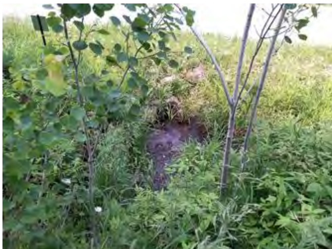
Vue amont de l'infrastructure existante
