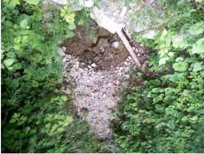
Vue aval de l'infrastructure existante
