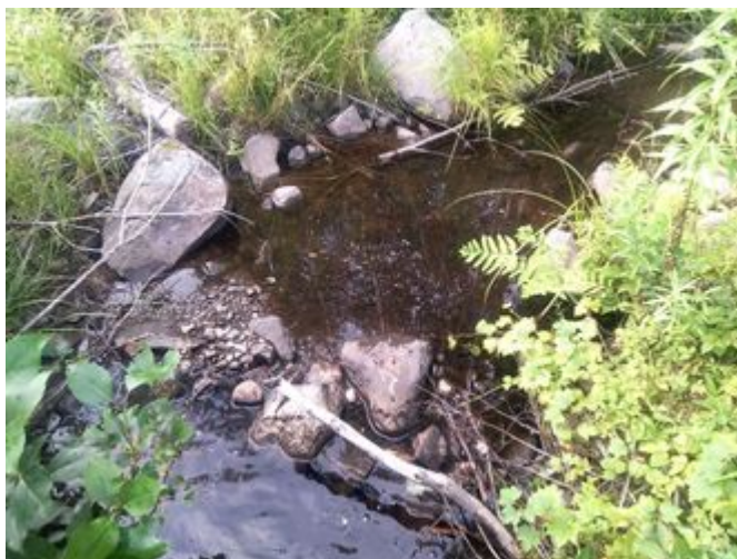
Vue aval de l'infrastructure existante
