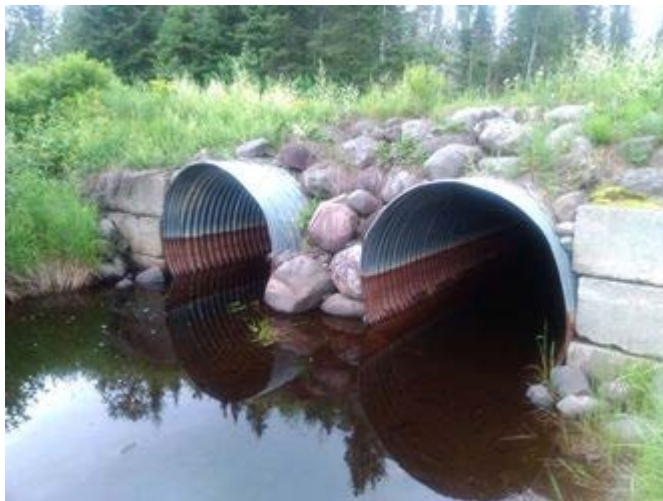
Vue aval de l'infrastructure existante
