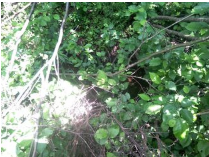
Vue amont de l'infrastructure existante
