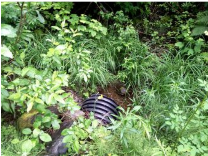
Vue amont de l'infrastructure existante
