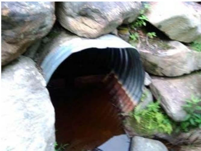
Vue amont de l'infrastructure existante
