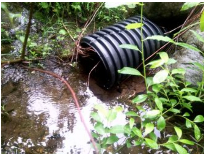
Vue amont de l'infrastructure existante
