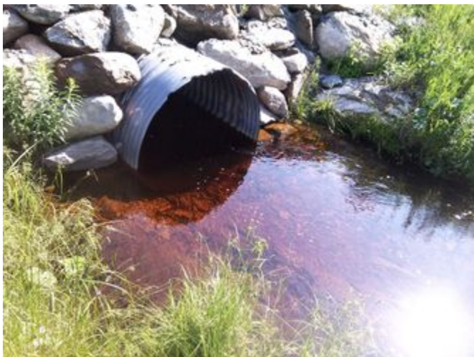
Vue amont de l'infrastructure existante
