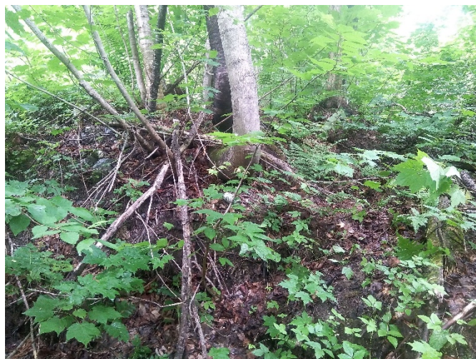
Talus, rive gauche
