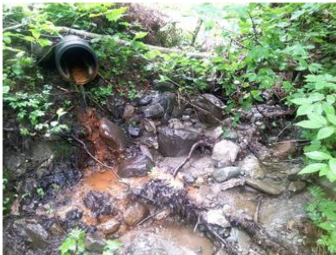
Vue aval de l'infrastructure existante
