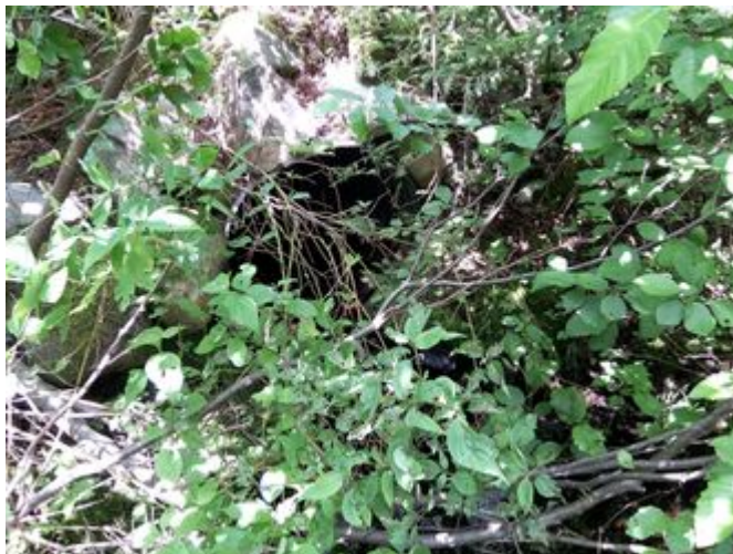
Vue aval de l'infrastructure existante
