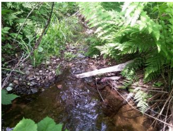
Vue aval de l'infrastructure existante
