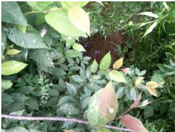
Vue aval de l'infrastructure existante
