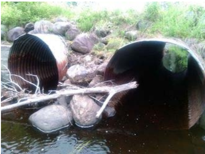
Vue amont de l'infrastructure existante
