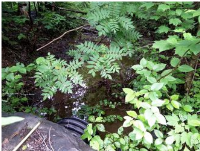
Vue aval de l'infrastructure existante
