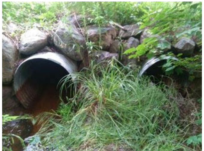
Vue aval de l'infrastructure existante
