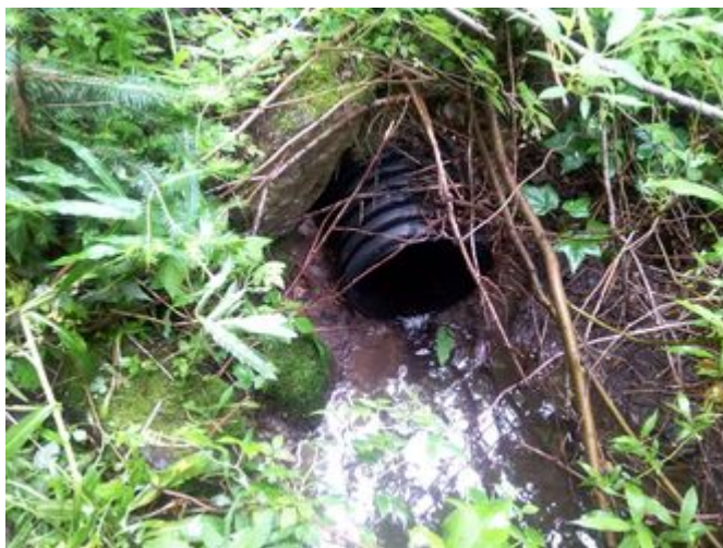
Vue aval de l'infrastructure existante
