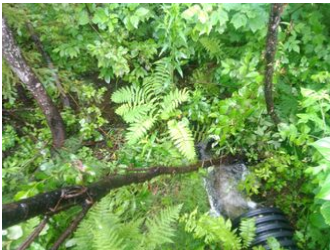
Vue aval de l'infrastructure existante
