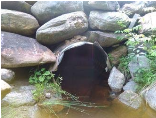
Vue aval de l'infrastructure existante
