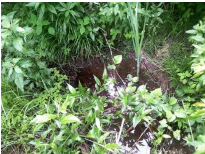
Vue amont de l'infrastructure existante
