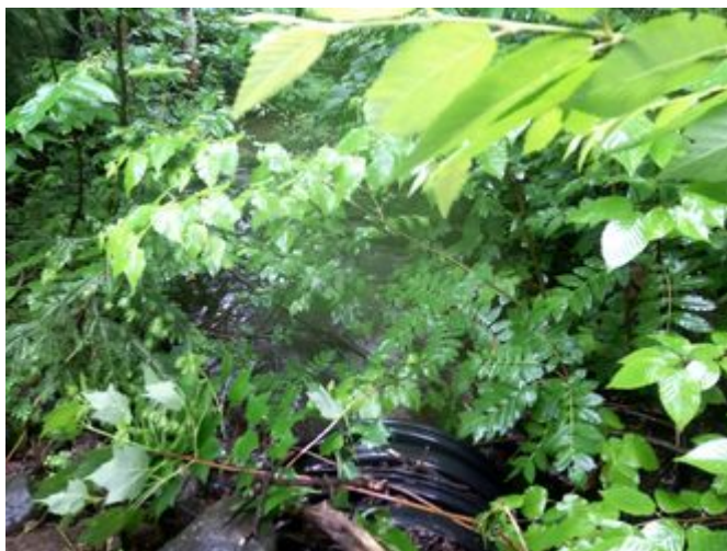
Vue aval de l'infrastructure existante
