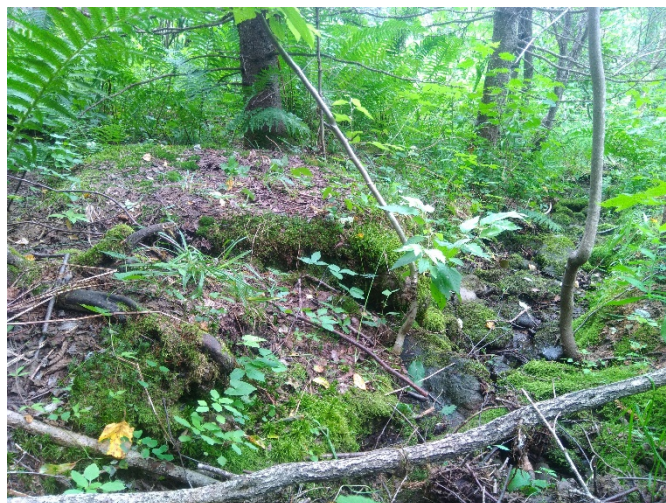
Talus, rive gauche
