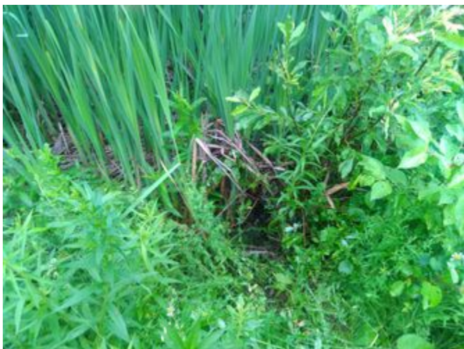
Vue amont de l'infrastructure existante
