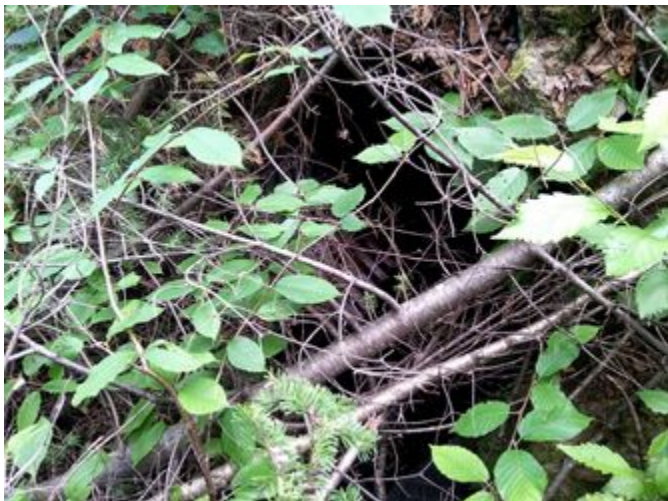
Vue amont de l'infrastructure existante
