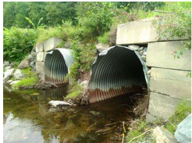
Photo 10. Ponceau double du ruisseau Turner (SH0020)
