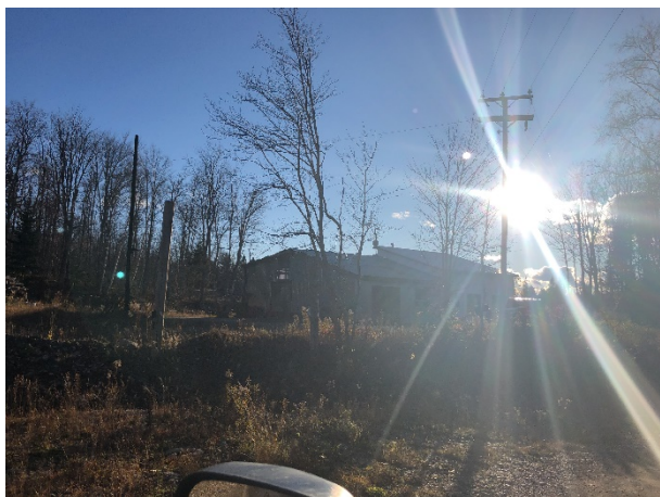
Photo 3. Bâtiments, érablière Pro-Bel inc.
