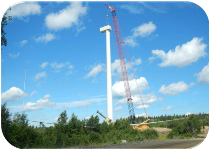
Mise en place de la nacelle
