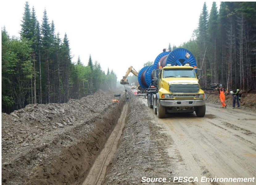
Figure 8. Installation d'un réseau collecteur souterrain
