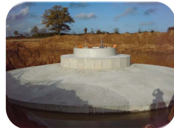
Coulage du béton
