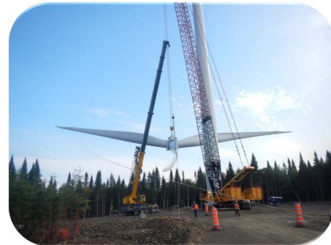
Installation du rotor
