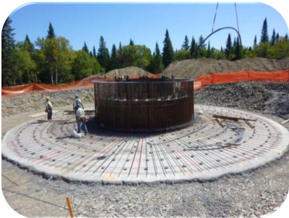
Installation de l'armature
