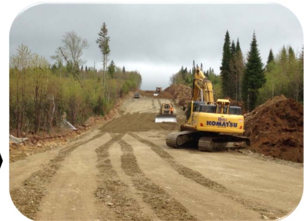
Construction des nouveaux chemins
