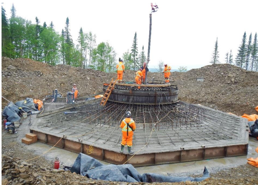
Figure 6. Construction d'une fondation d'éolienne circulaire
