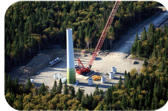
Assemblage de la tour
