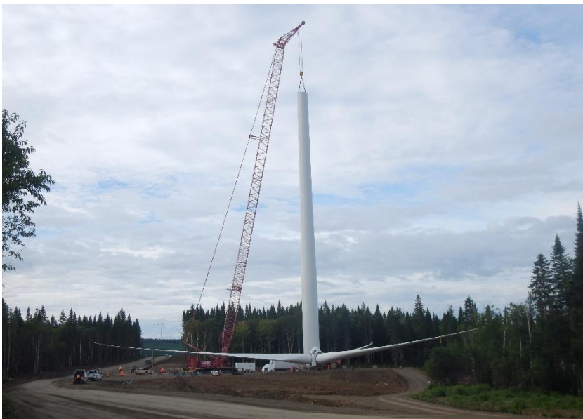
Figure 7. Assemblage d'une tour d'éolienne par section
