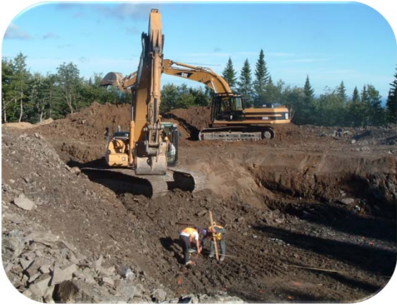
Excavation de la fondation
