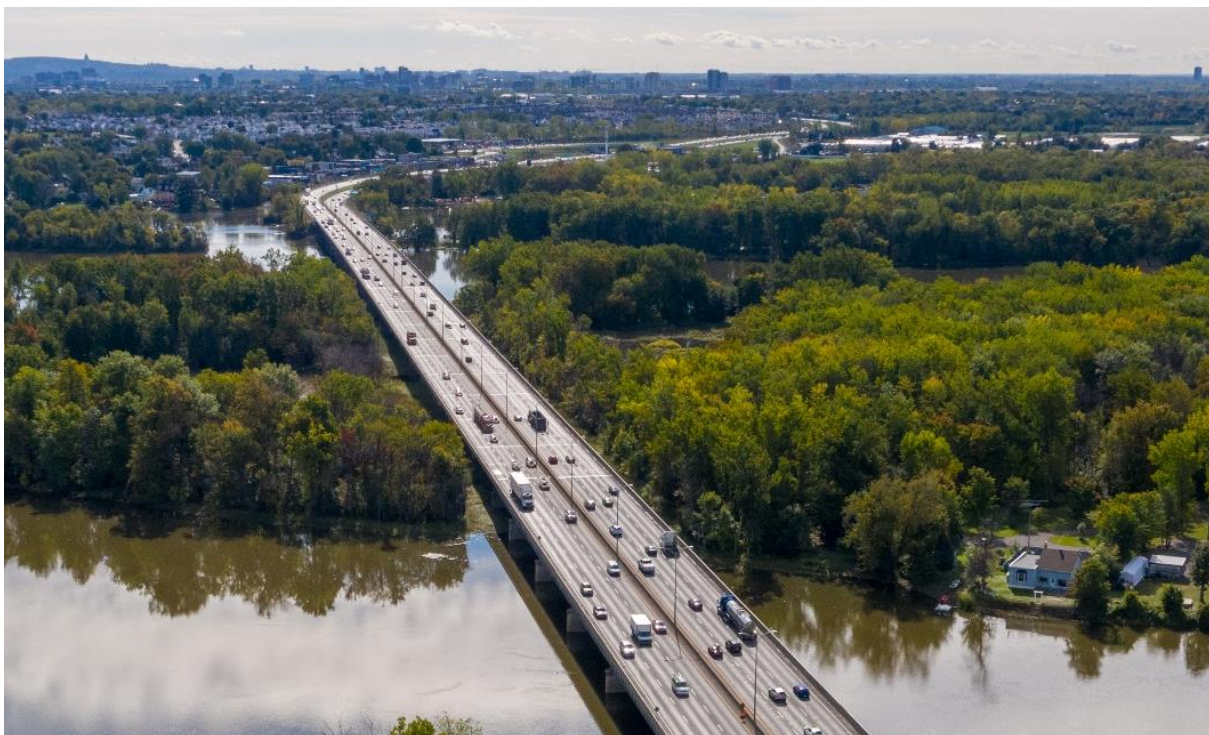
Pont Gédéon-Ouimet – Vue en direction sud
