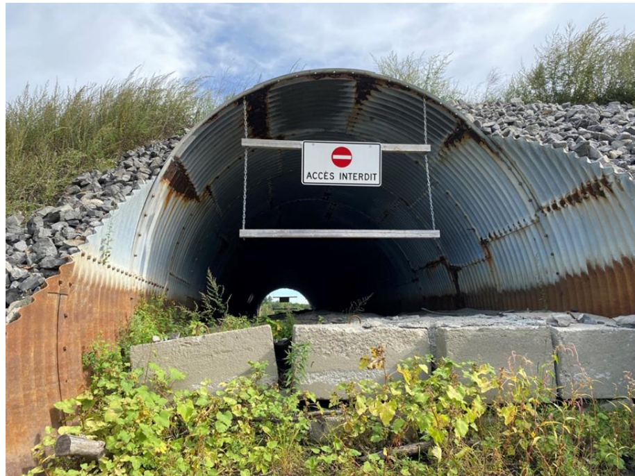
Figure 6.11 : Radier comblé et présence de blocs de béton à l'entrée du ponceau, sous la jetée de l'approche sud
