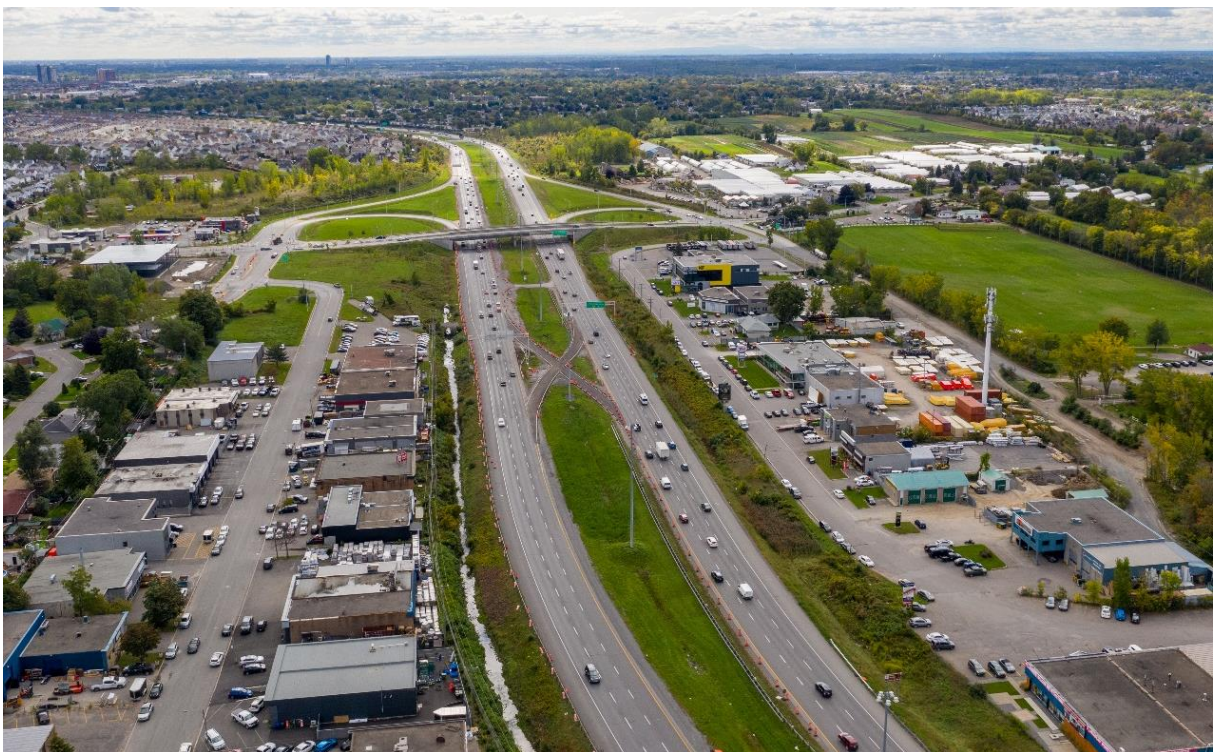
Approche sud – Vue en direction sud
