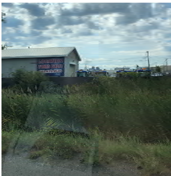
Photo 35 – Vue de l'entrepasage d'équipement de déneigement observé depuis la bretelle d'insertion sur l'A15 au niveau du km 7+700. (Source : photographie prise le 9 septembre 2021)
