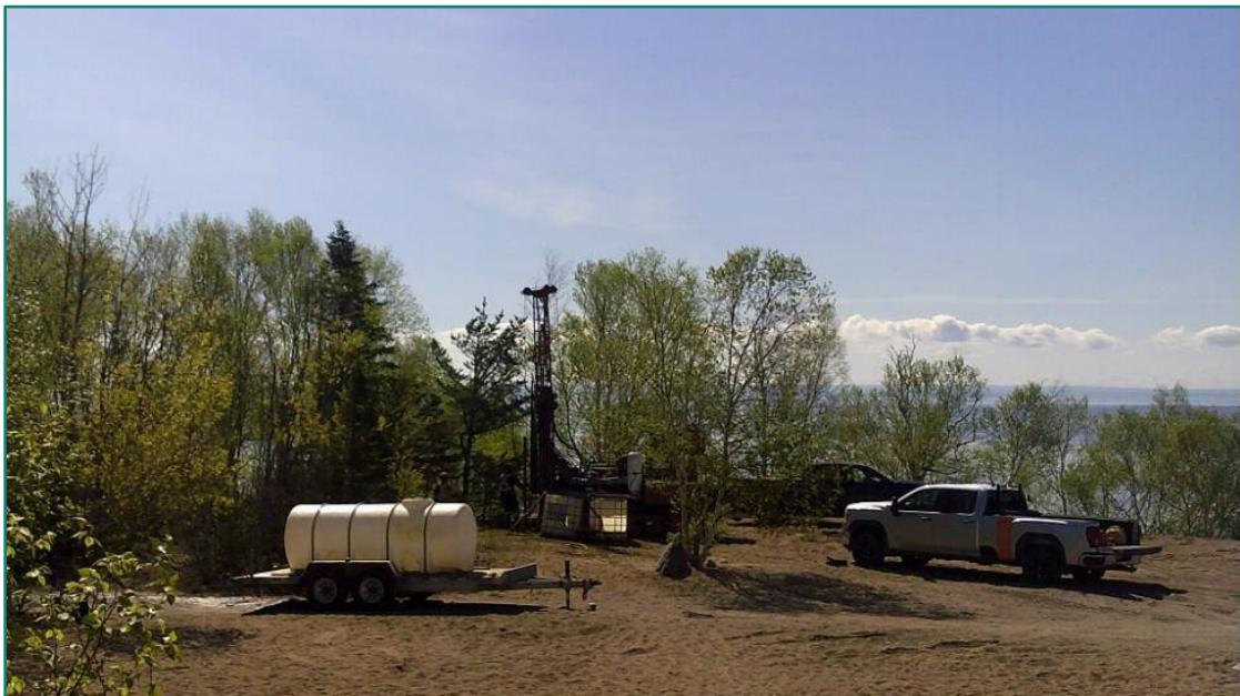
Photo 1 : Vue montrant la réalisation du sondage TF-01-22, en mai 2022.
