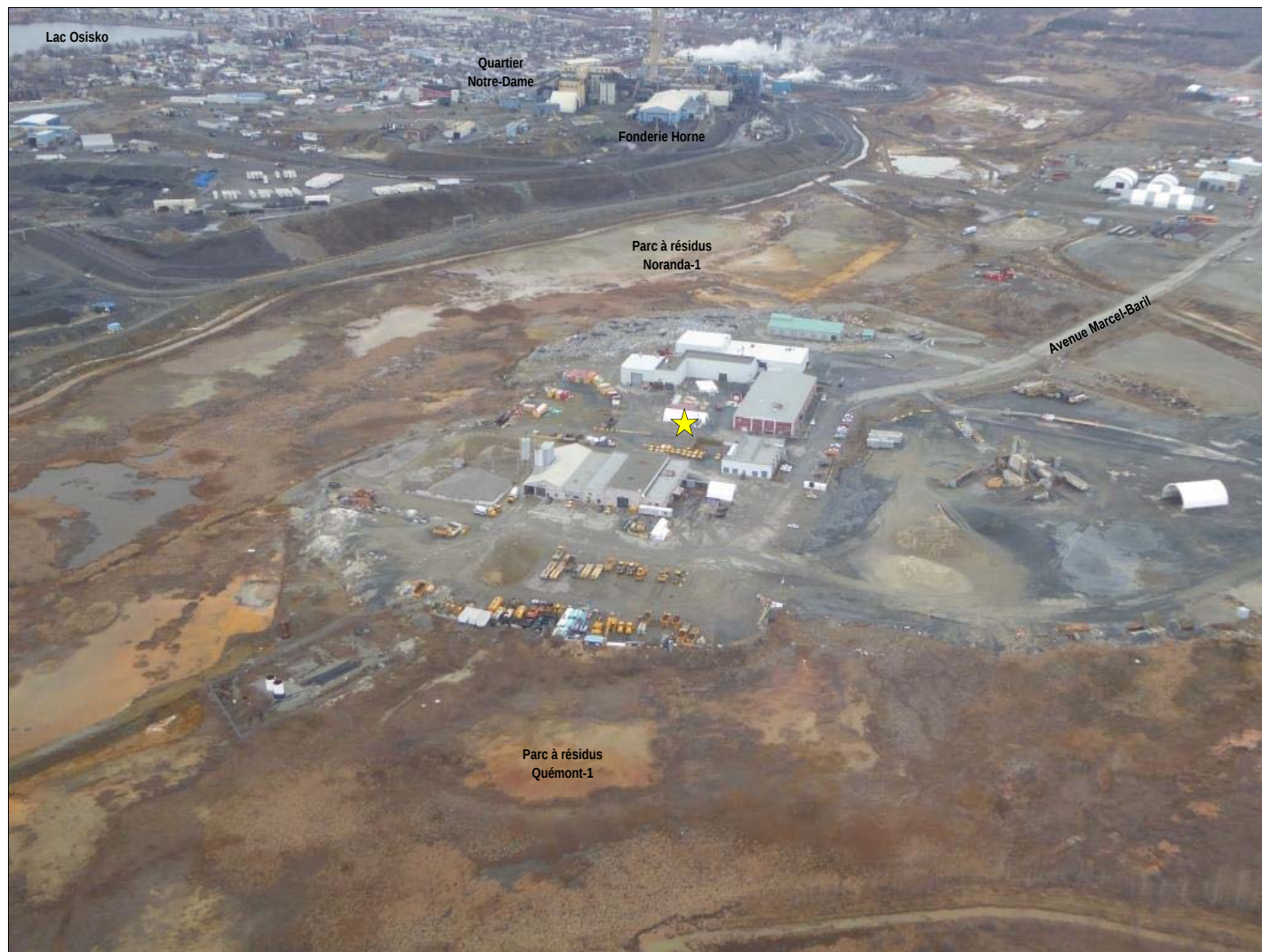
Photo 2 : Vue aérienne du secteur d'implantation du projet
