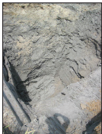
Photo 1 Vue d'une première tranchée exploratoire lors de l'évaluation du matériel pour la conception d'une réserve d'eau sur le lot 6 444 065 à Sainte-Anne-de-Sorel.
