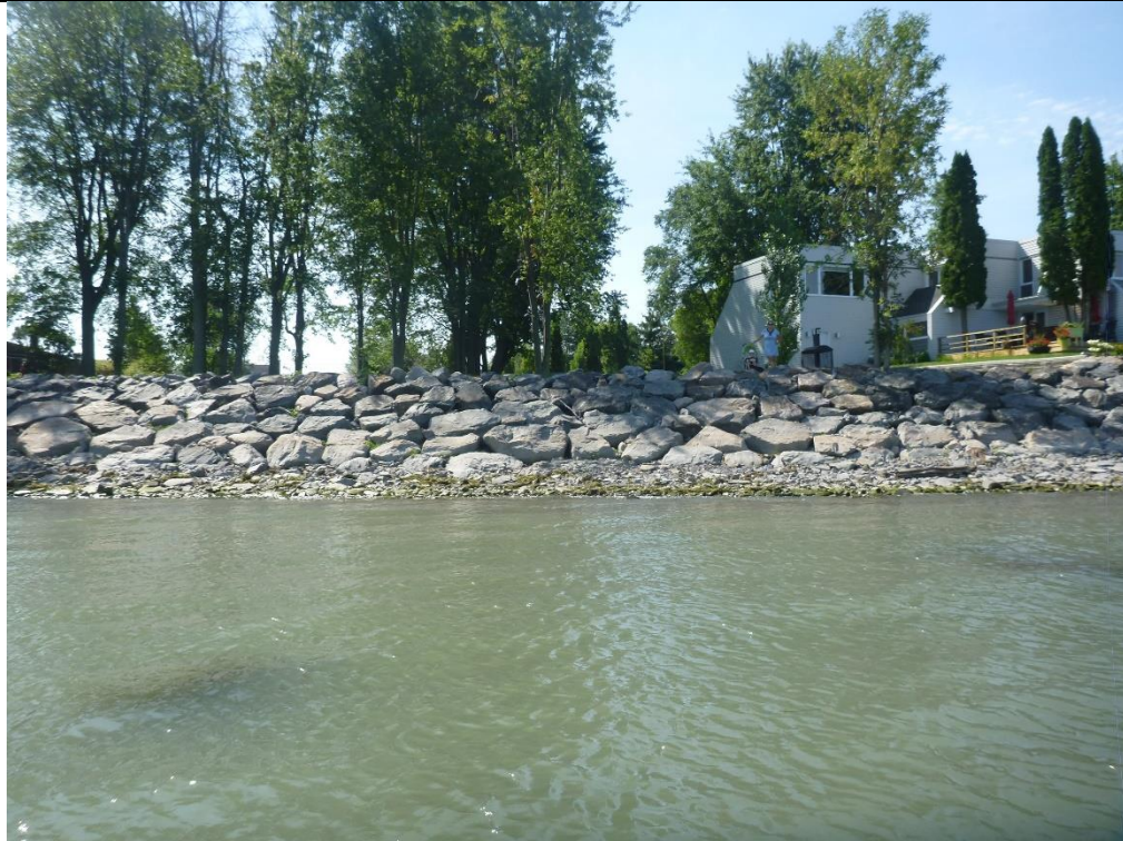
PHOTO 1 Berge à l'endroit où débutera la conduite
