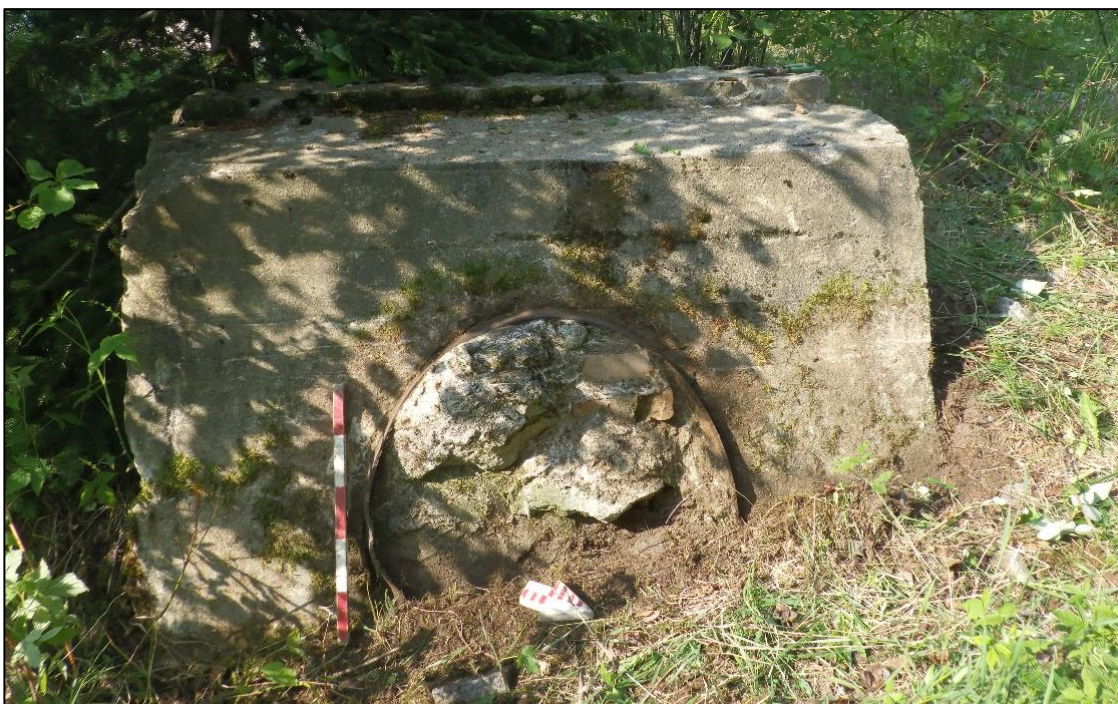
Photo 24. Entrée de la conduite forcée visible dans le mur nord de la centrale hydro-électrique (DaEj-30-7L100B), vers le sud-ouest (23-CIET-04-029). Celle-ci a été bouchée au moyen de béton et de briques lors de l'abandon de la centrale vers le milieu des années 1960.
