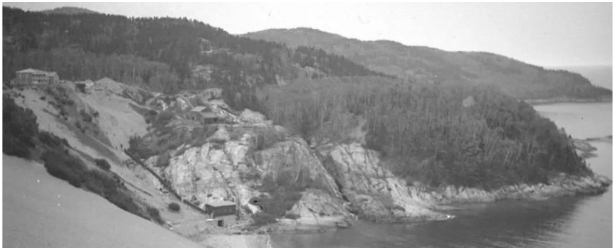
Figure 44. Photo prise vers 1945 sur laquelle apparaissent la maison des Dunes, la conduite forcée et la centrale hydro-électrique (Tirée du site Internet https://www.tidesoftadoussac.com/fr/dunes ). Le passage de la conduite semble avoir grandement modifié la topographie originale du talus et altéré le débit de la branche est de la rivière.
