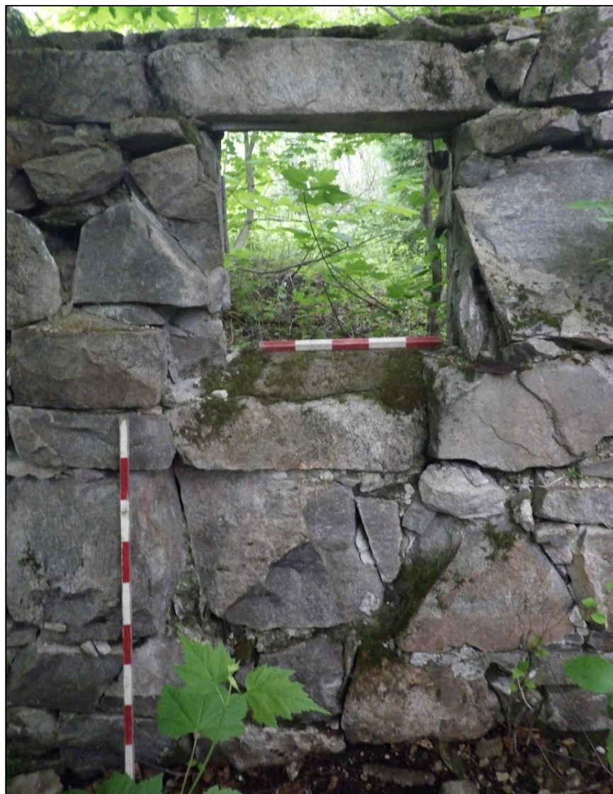
Photo 18. Détail d'une fenêtre perçant le mur nord du moulin à scie des années 1940 (DaEj-3-7N100b), vers le nord (23-CIET-04-204)
