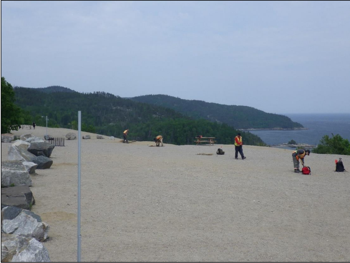
Photo 27. Vue générale des travaux réalisés dans la zone 5, vers le nord-est (23-CIET-04-136)
