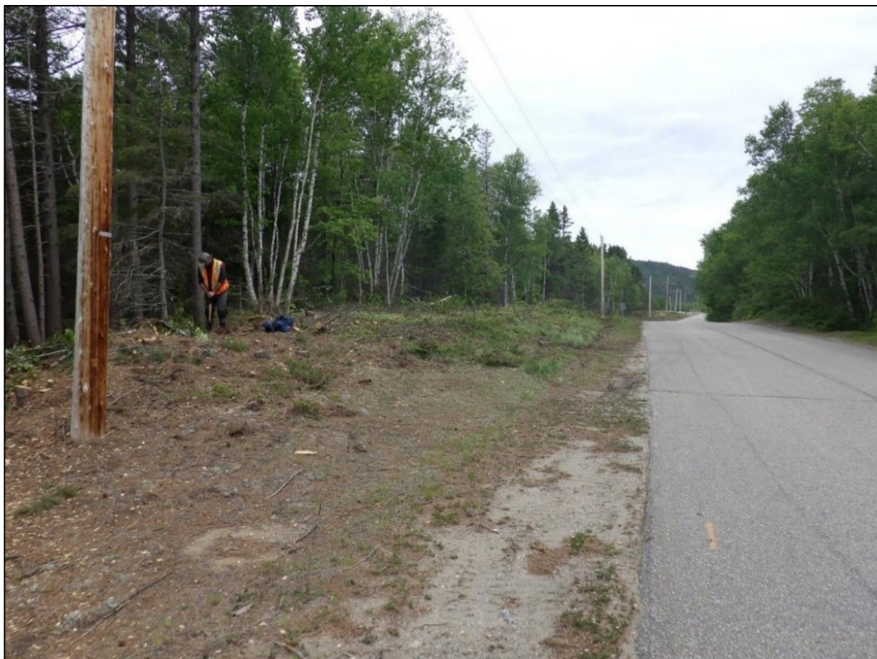
Photo 30. Vue générale de la zone 6 localisée en bordure du chemin du Moulin à Baude, vers l'ouest (23-CIET-04-252)
