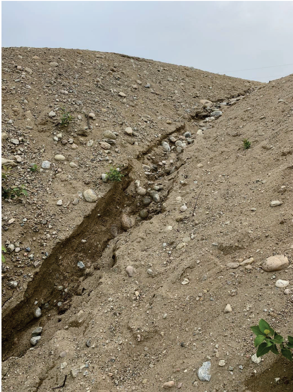
Figure 3-16 : Zone de ravinement 4 (amont)
