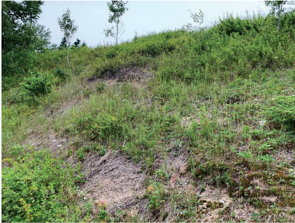
Figure 3-23 : État du sommet de talus au droit de la maison des dunes
