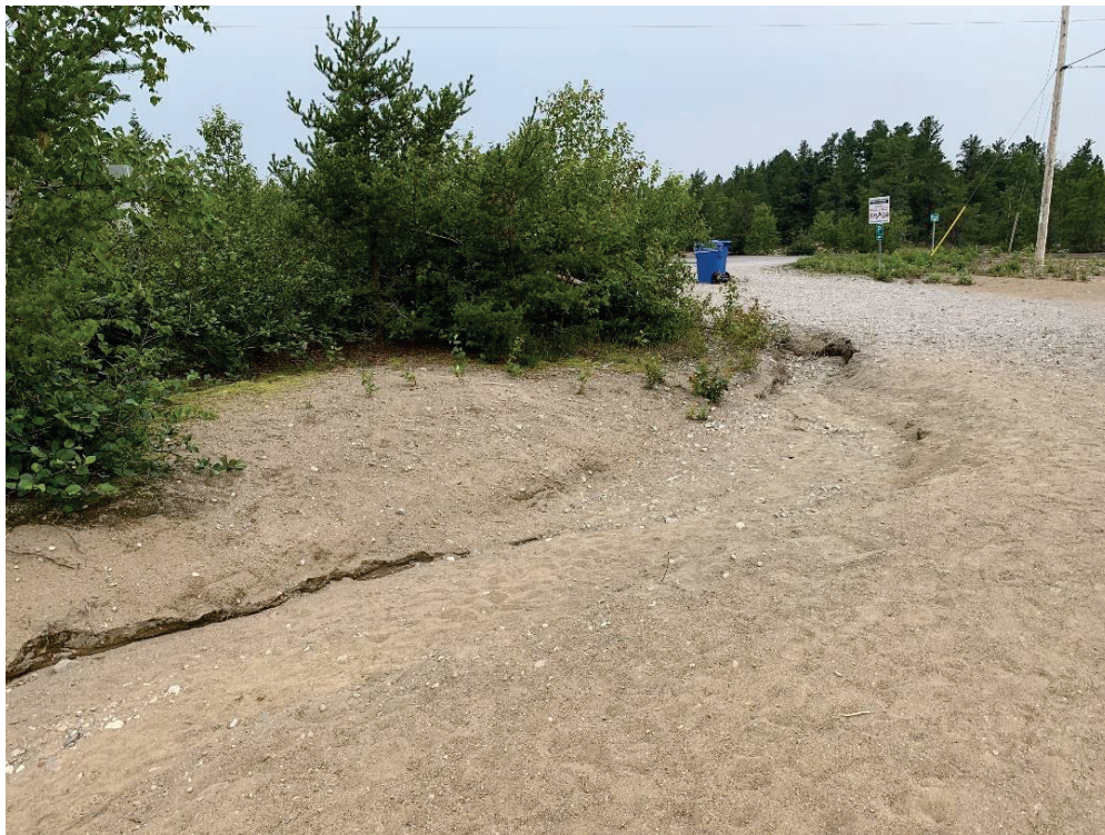
Figure 3-6 : Zone de ravinement 1 (amont)
