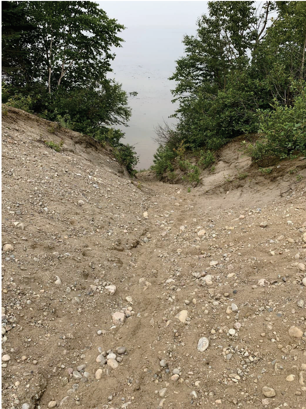
Figure 3-18 : Zone de ravinement 5 (amont)
