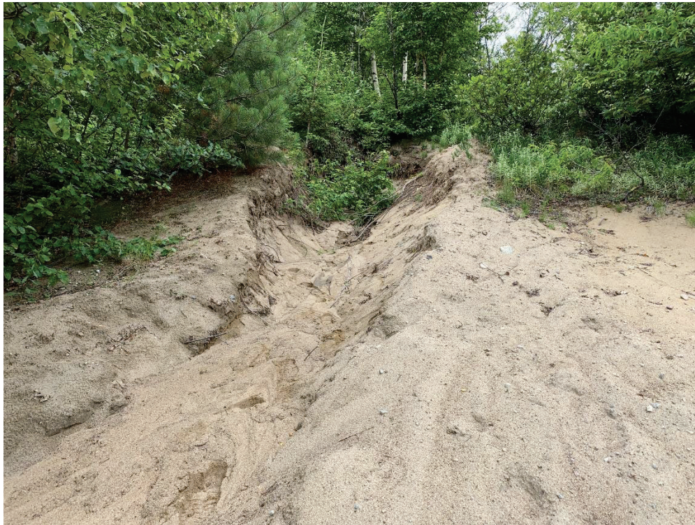
Figure 3-14 : Zone de ravinement 3 (aval)
