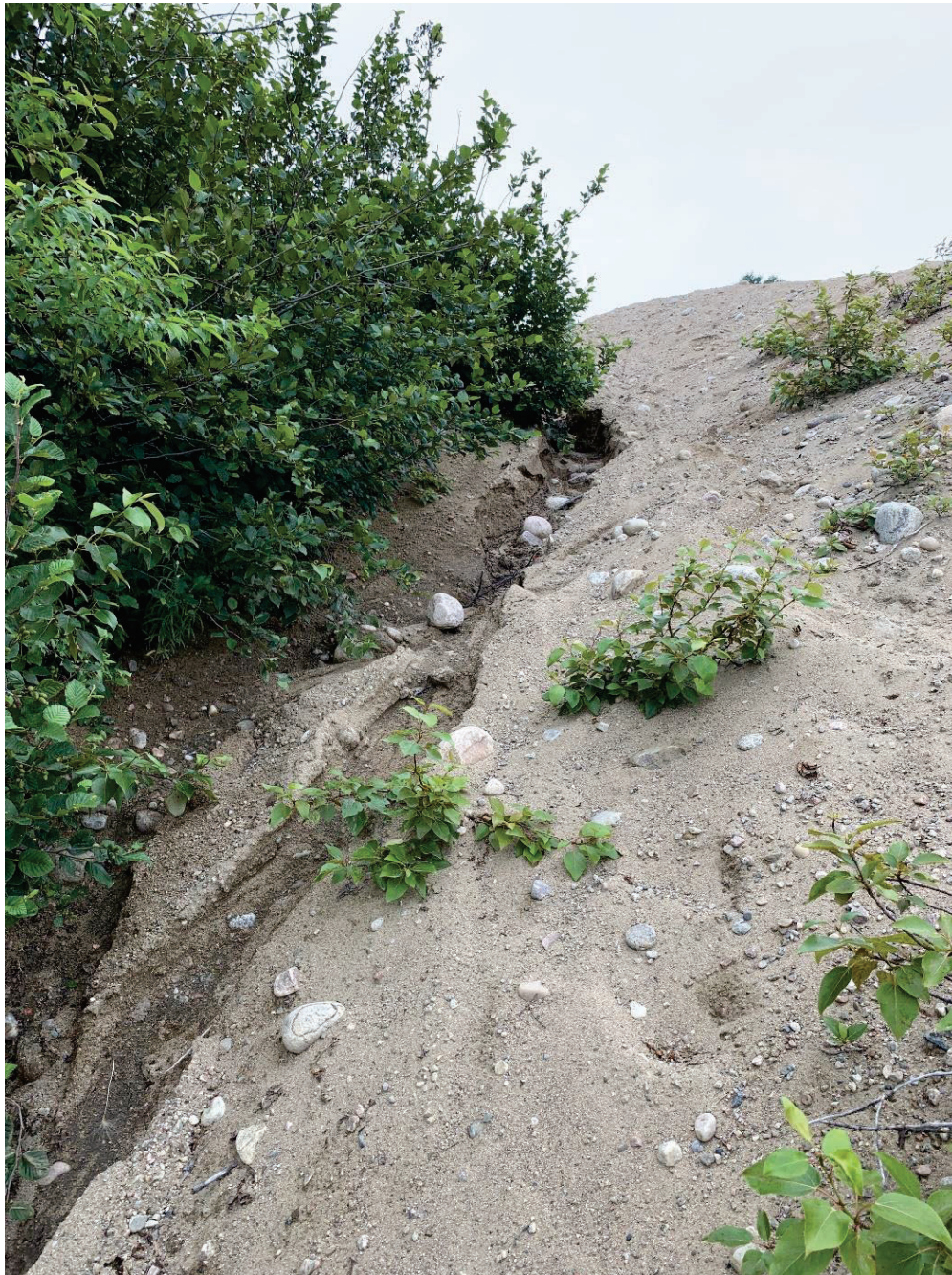
Figure 3-17 : Zone de ravinement 4 (milieu et aval)
