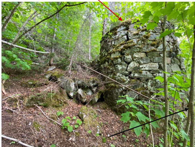
Figure 9 : Structure du four adossée à la falaise. Cheminée (rouge) et l'entrée du feu (noir). Elizabeth Cloutier © CCQ/MCC.
