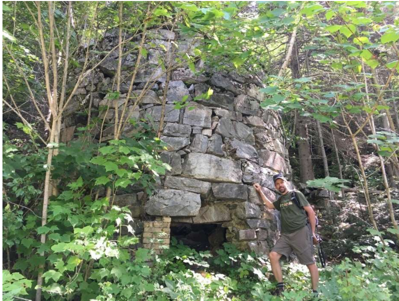
Figure 38. L'un des trois fours à chaux de la Grande Anse. La structure imposante de pierre est encore bien droite (Marc-André Villard, août 2020).
