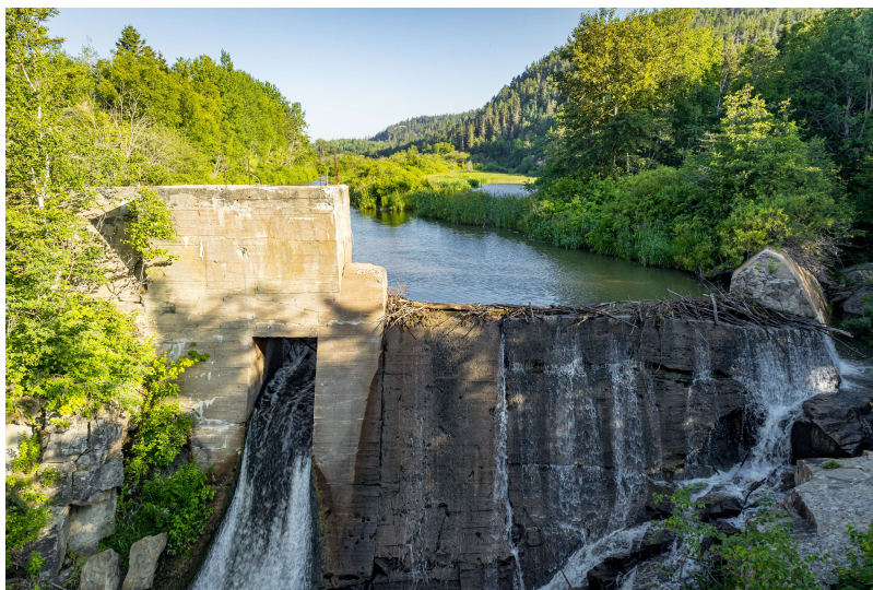
Figure 12. Le barrage de la rivière du Moulin à Baude (Mathieu Dupuis, 2021)
