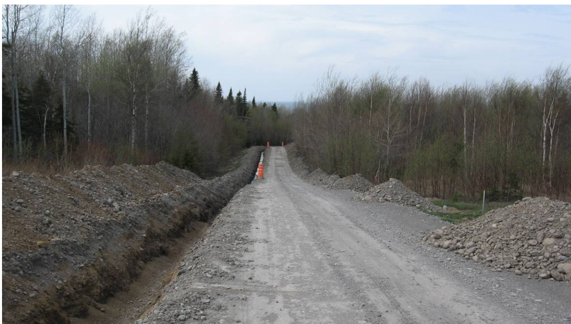
Figure 3.11 Tranchée requise pour l'enfouissement du réseau collecteur
