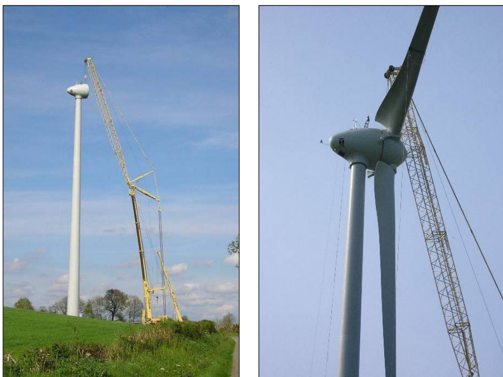
Figure 3.7 Installation de la nacelle et du rotor
