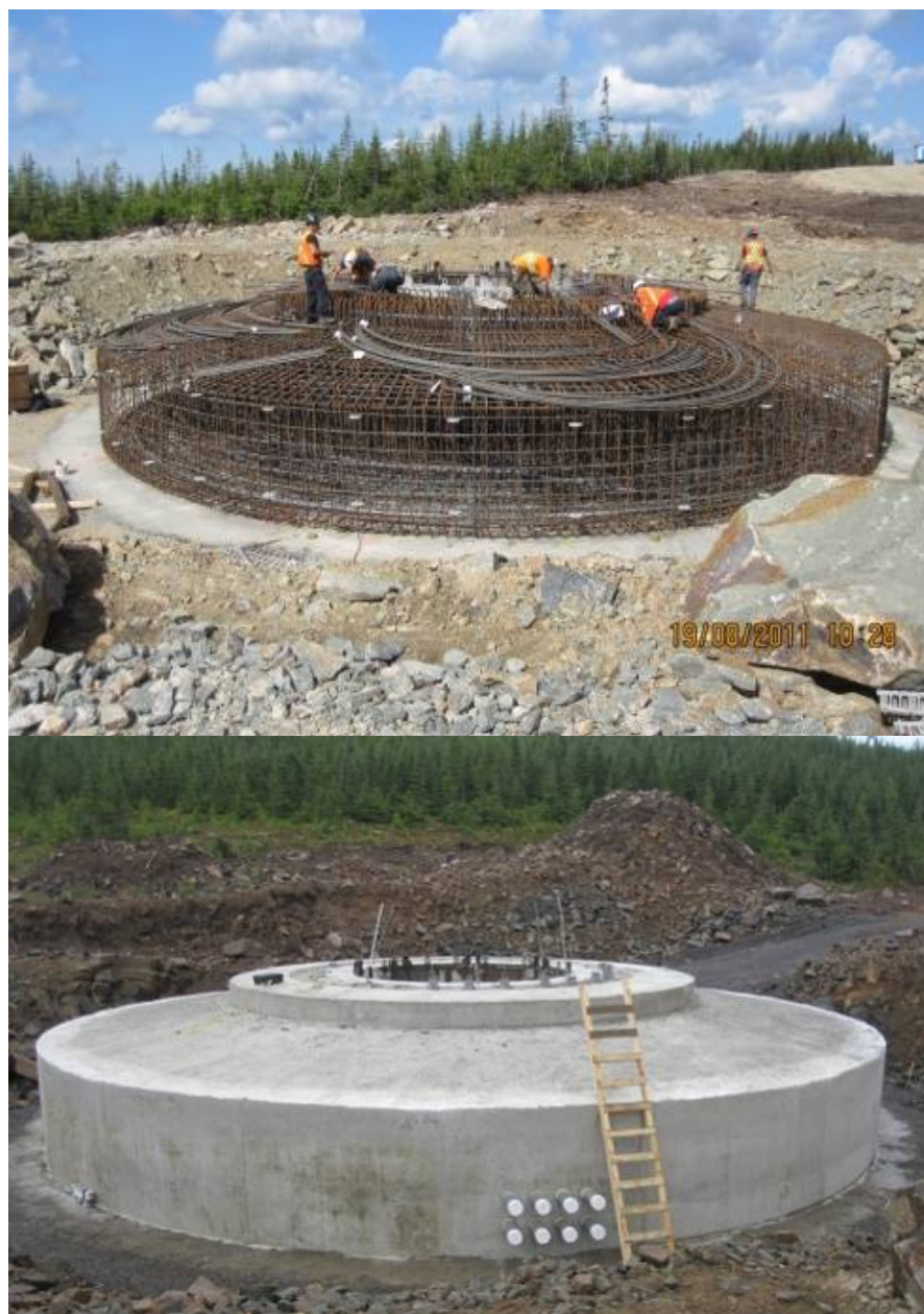
Figure 3.6 Fondation type d'une éolienne Enercon
