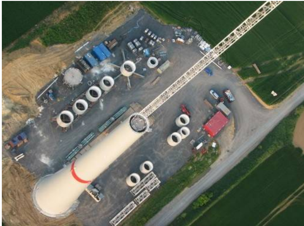
Figure 3.3 Aire de travail lors de l'érection de l'éolienne
