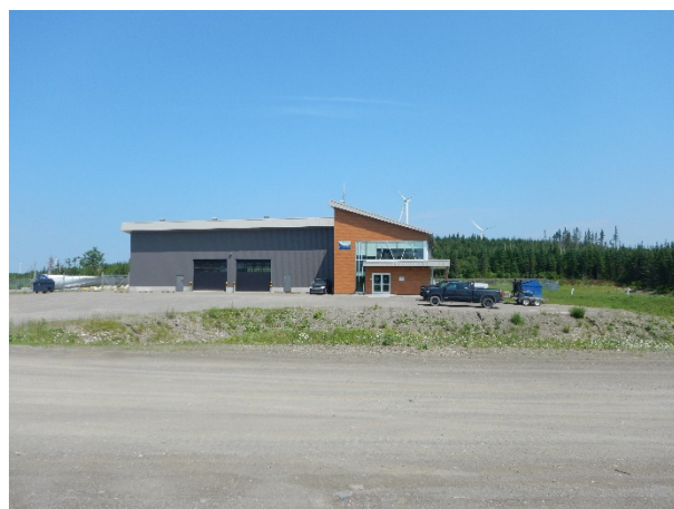
Photo 12. Bâtiment d'opération du parc éolien existant
