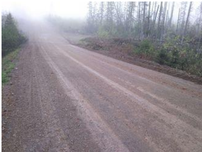
Chaussée de l'infrastructure existante
