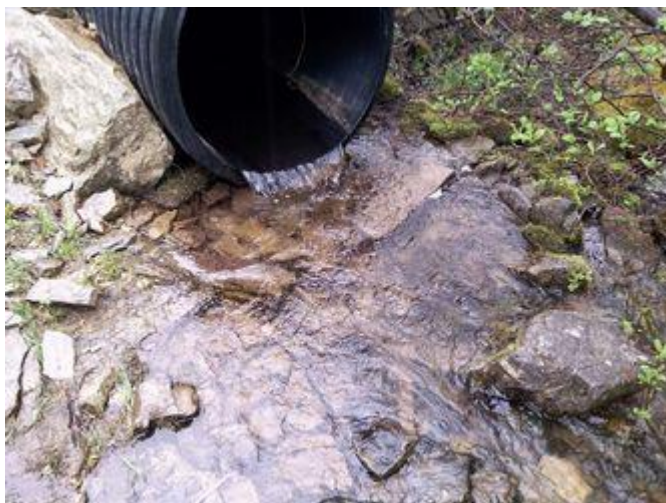
Vue aval de l'infrastructure existante
