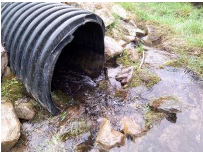
Vue amont de l'infrastructure existante
