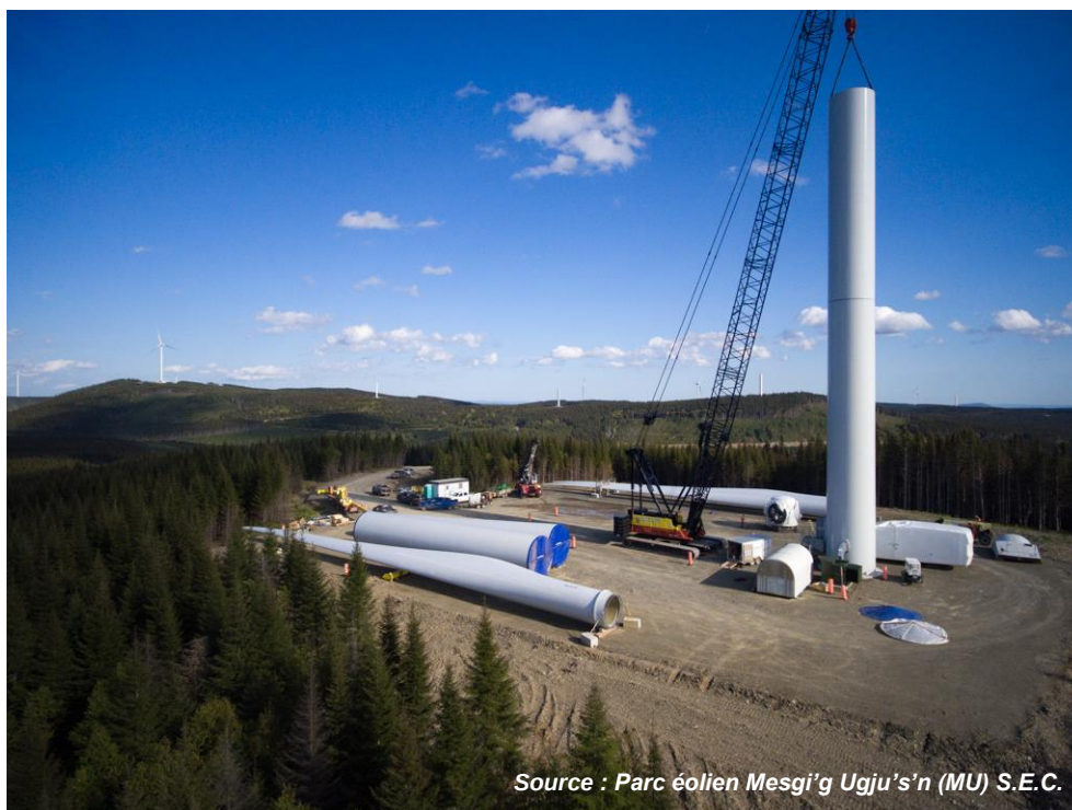
Figure 12. Assemblage d'une tour d'éolienne par section
