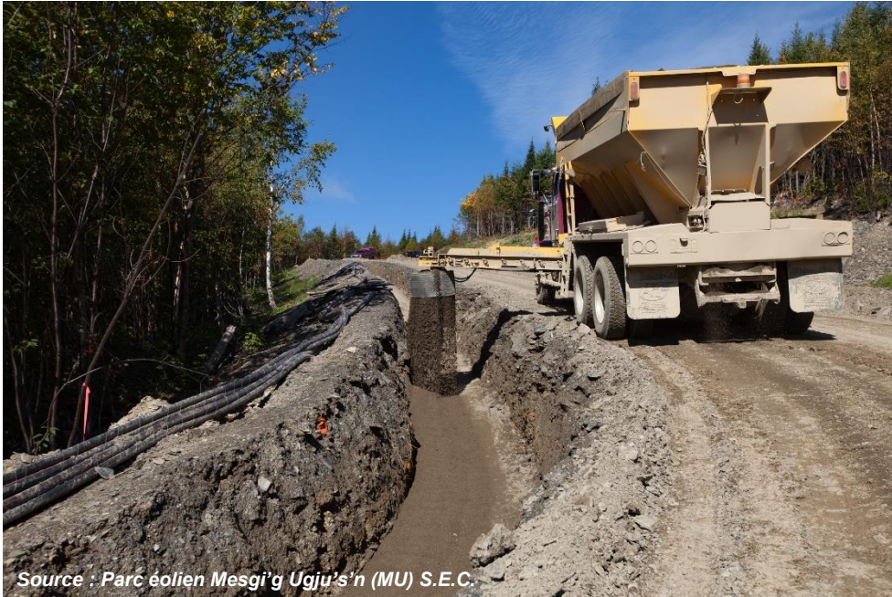
Figure 14. Installation d'un réseau collecteur souterrain
