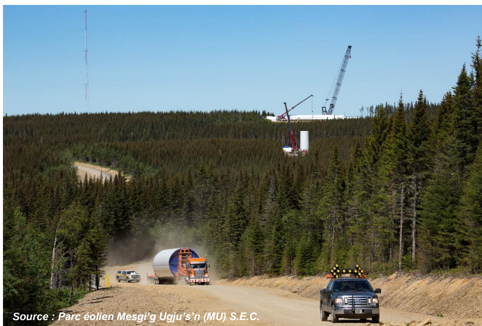
Figure 10. Camion transportant une section de tour d'éolienne
