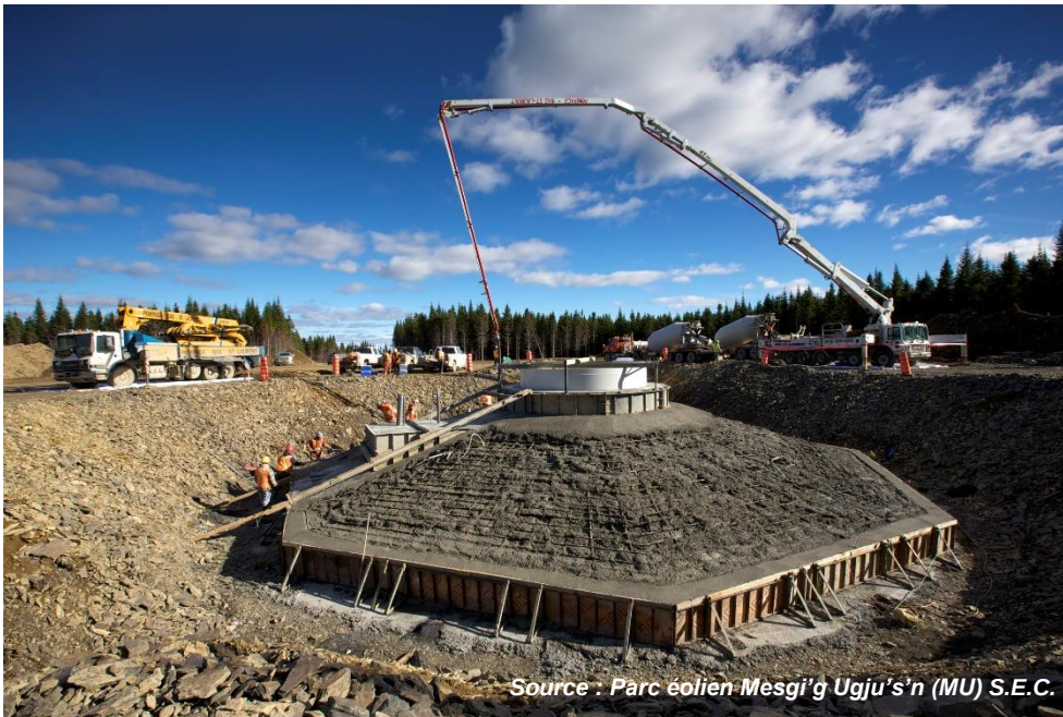
Figure 11. Construction d'une fondation d'éolienne
